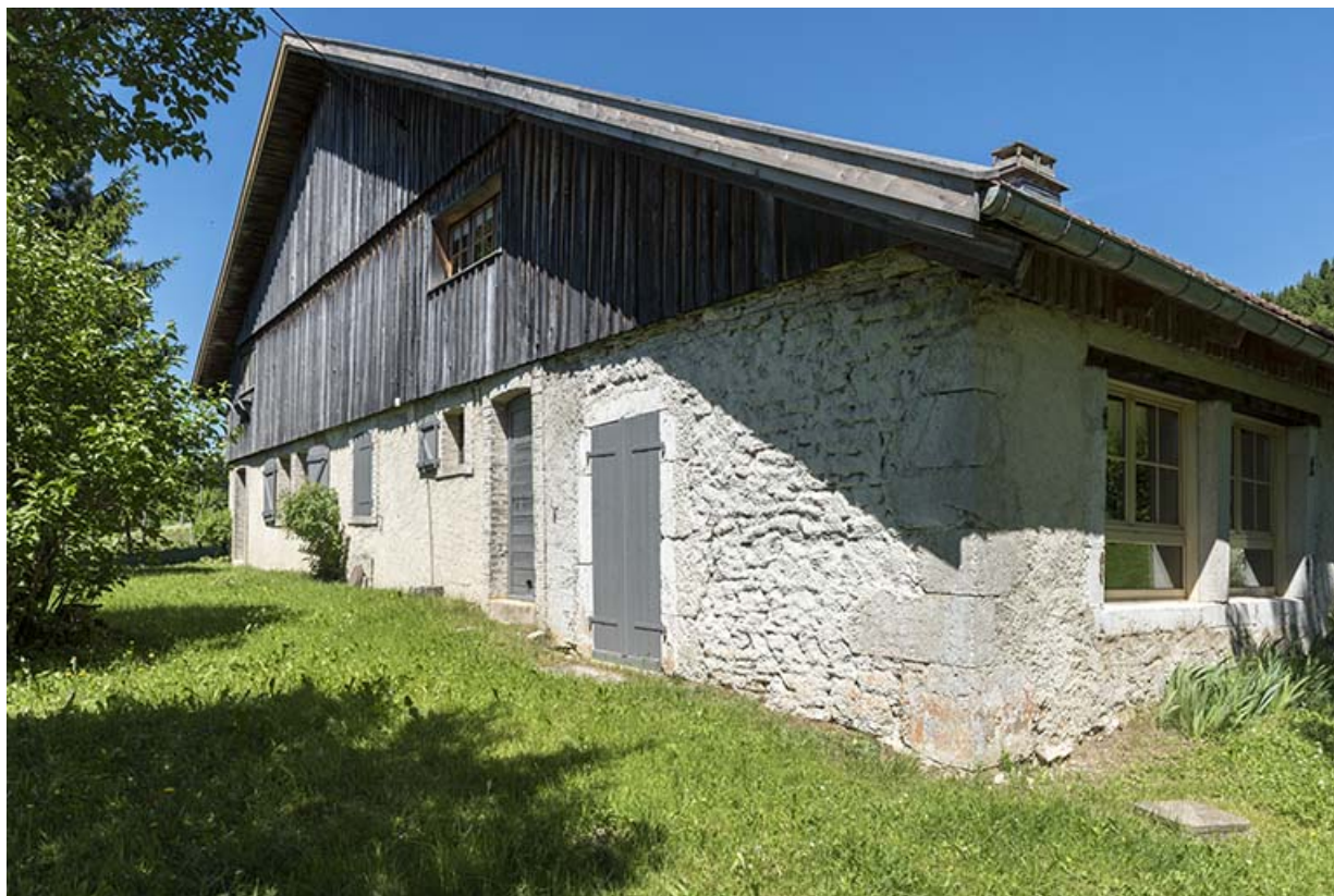
Élévation ouest, vue en enfilade.
