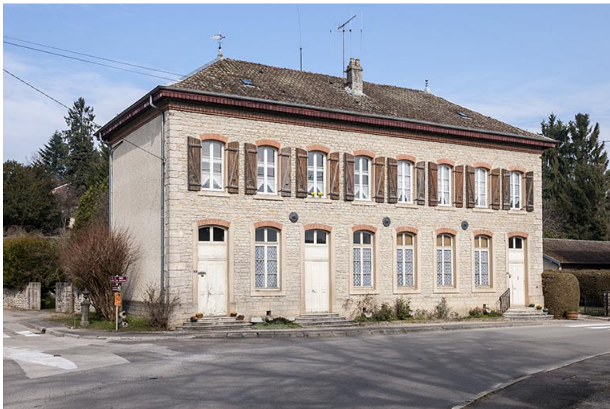
Bâtiment de l'école et du magasin coopératif. Vue d'ensemble.
