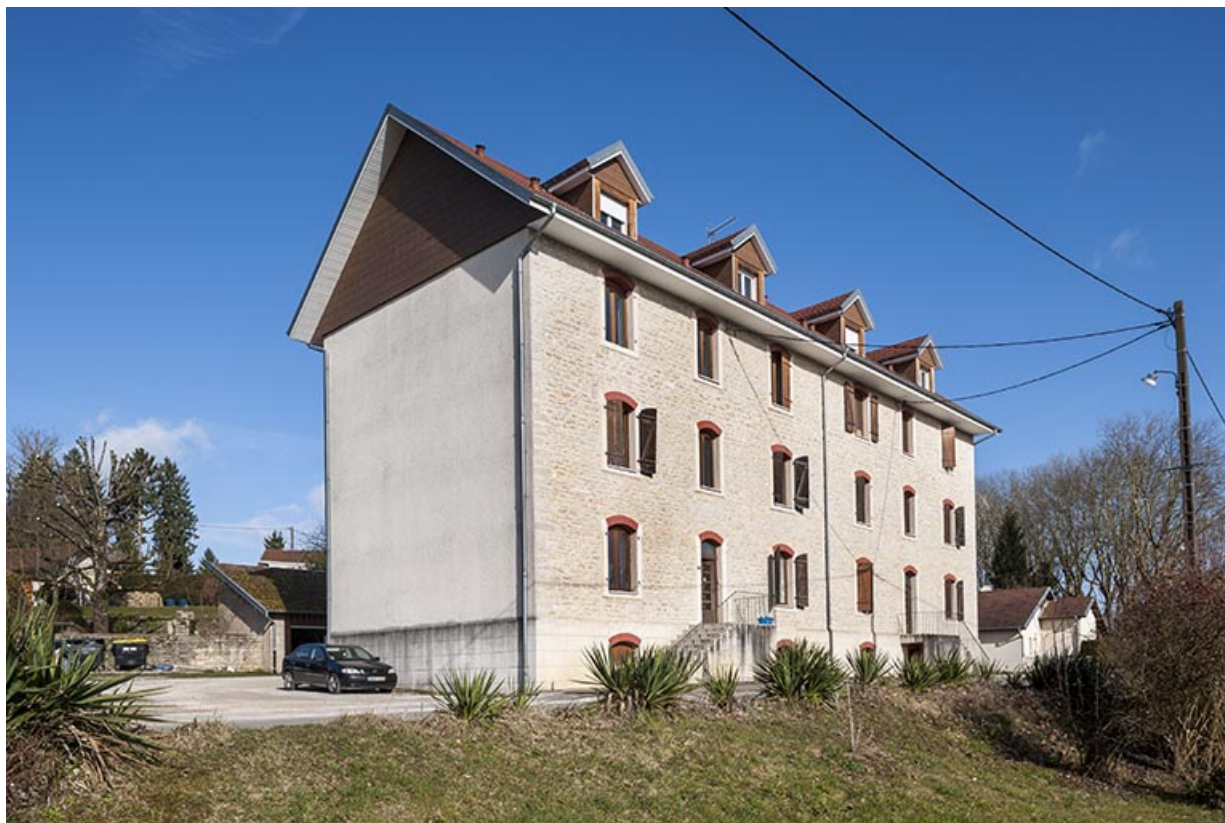
Immeuble de logements. Vue de trois quarts gauche.
