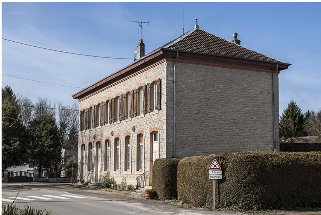
Bâtiment de l'école et du magasin coopératif vu de trois quarts droite.
