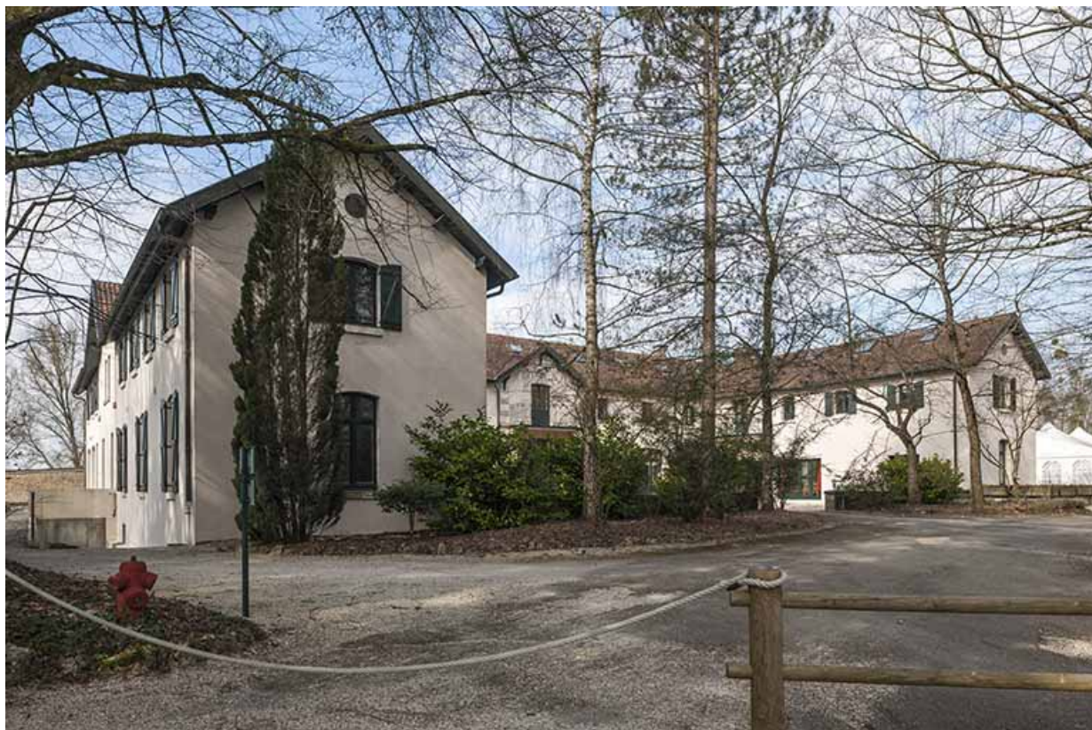
Bâtiment des communs. Vue depuis le sud-est. 25, Geneuille route des Papetiers
