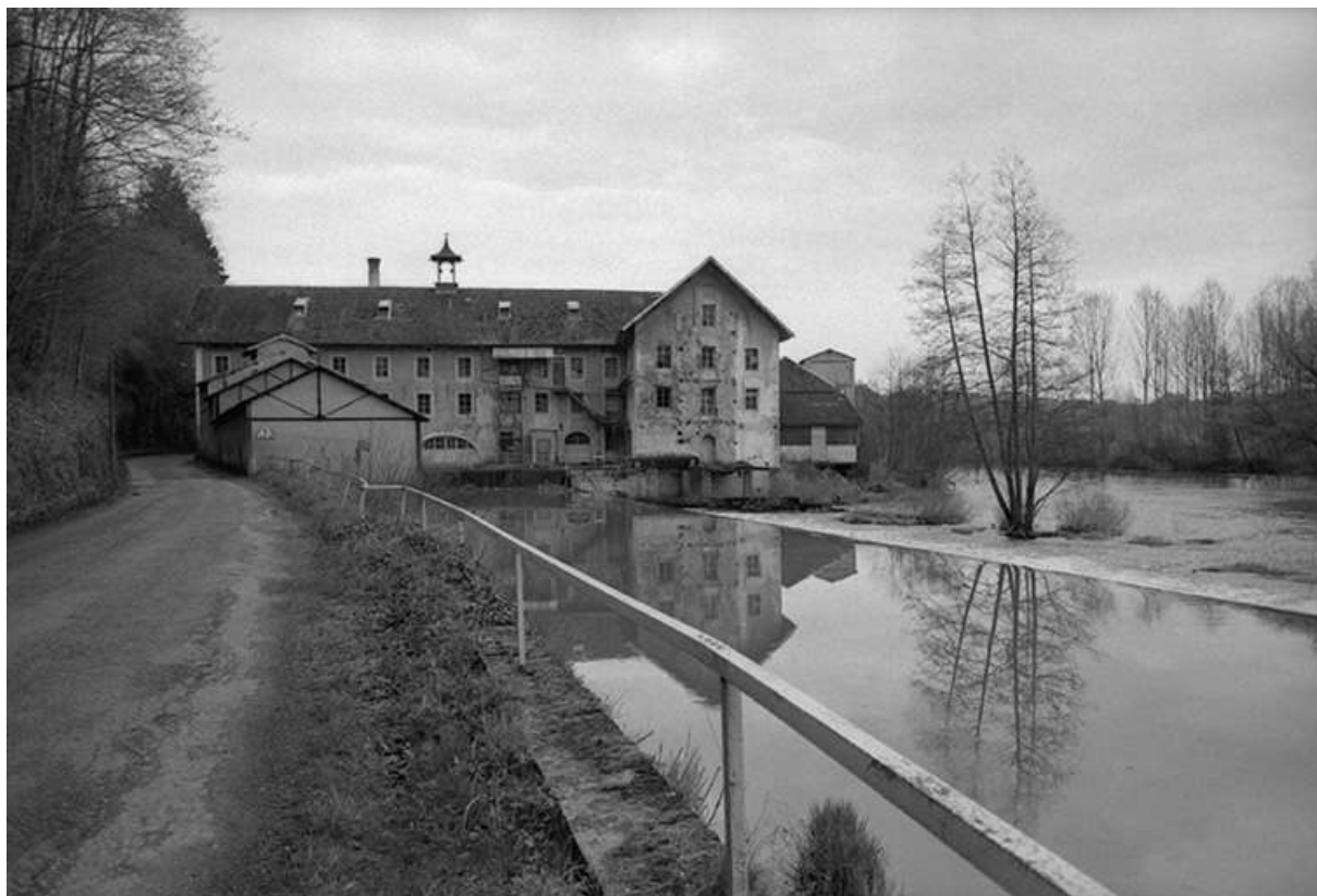
Vue d'ensemble de la papeterie en venant de Geneuille, de gauche à droite (A-D-E). 25, Geneuille route des Papetiers
