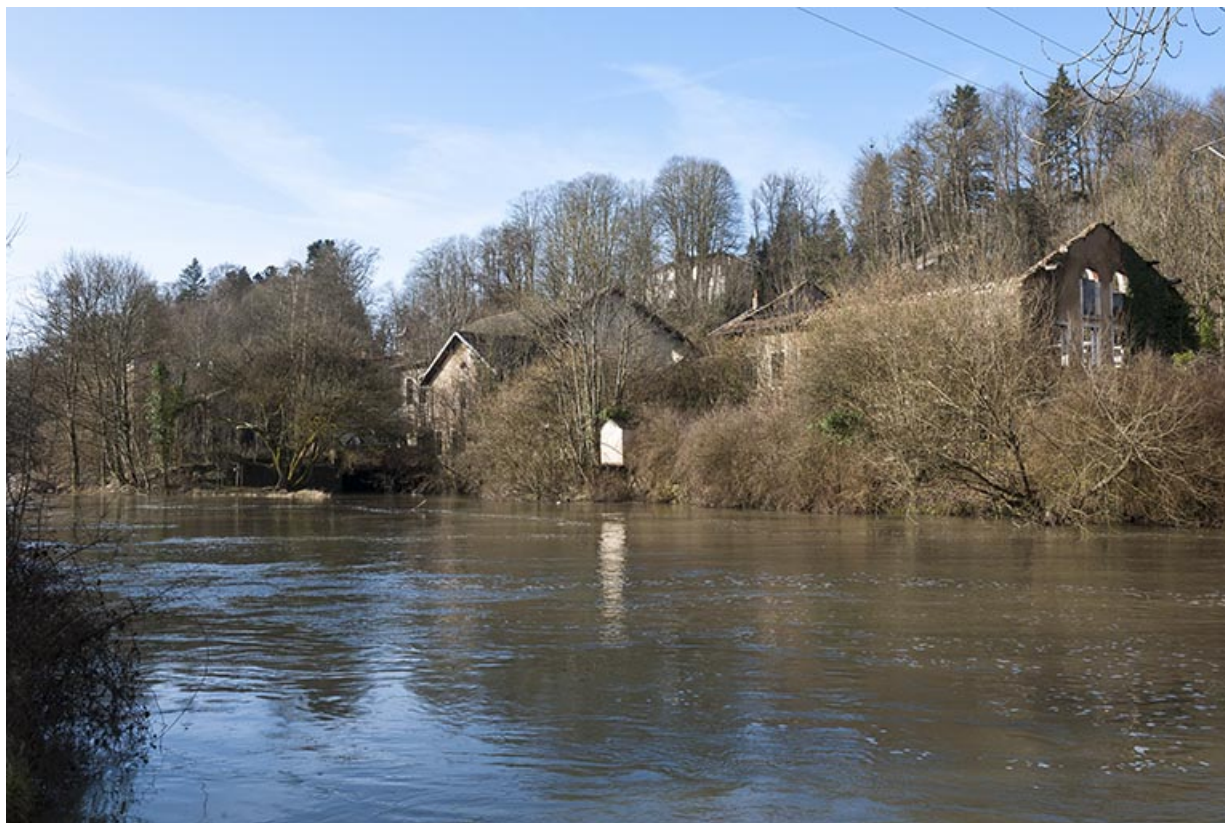
Vue d'ensemble depuis la rive droite, en aval. 25, Geneuille route des Papetiers
