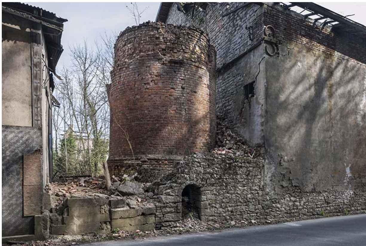
Base de la cheminée et la chaufferie.
