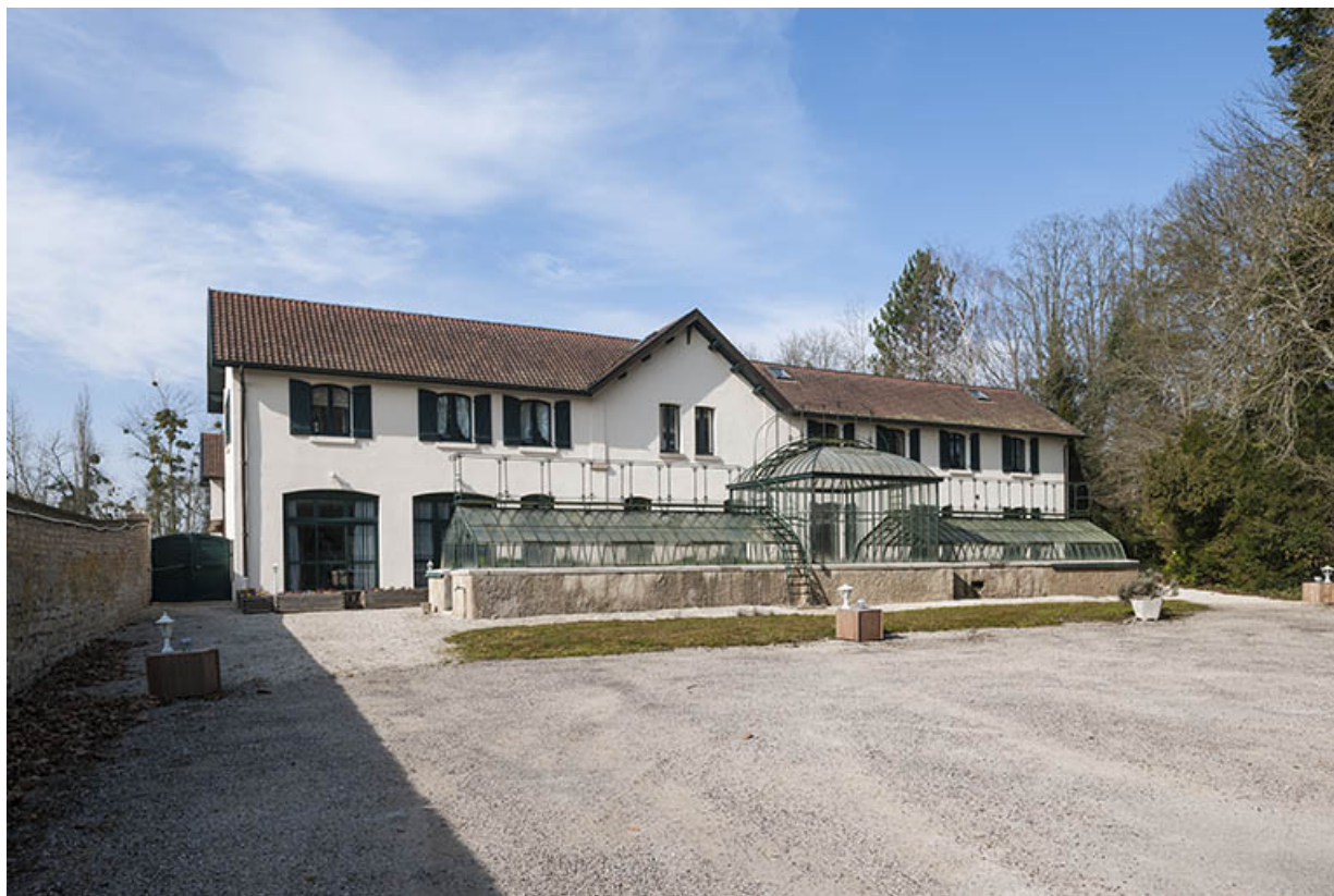
Façade postérieure des communs, et la serre. 25, Geneuille route des Papetiers
