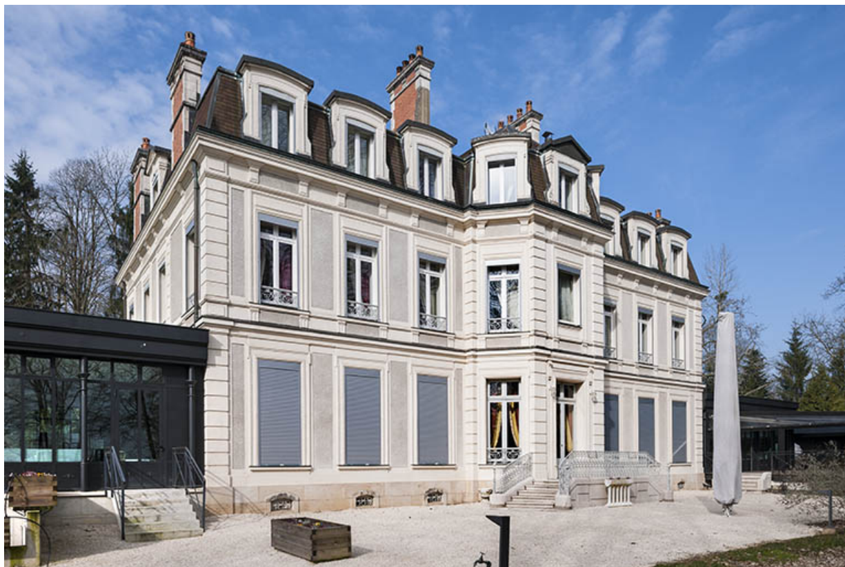
Logement patronal. Vue de trois quarts gauche. 25, Geneuille route des Papetiers
