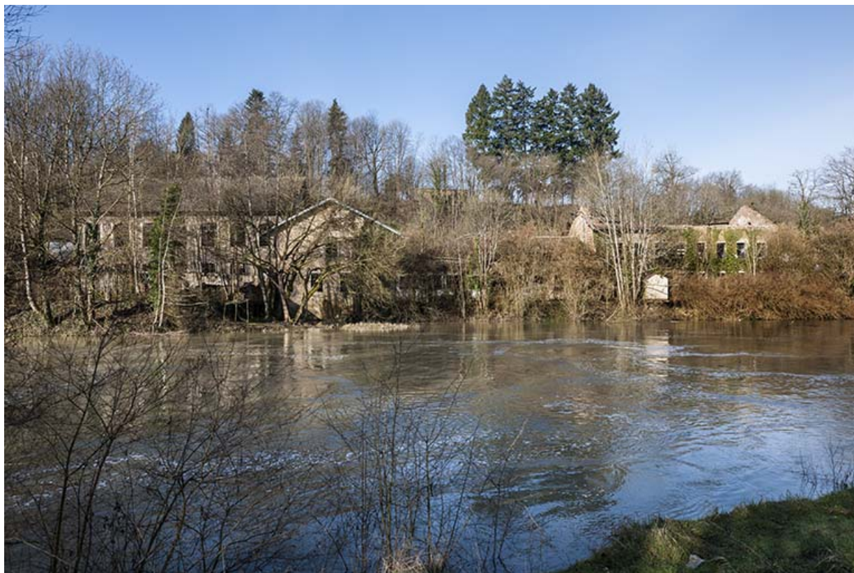
Vue d'ensemble depuis la rive droite.
