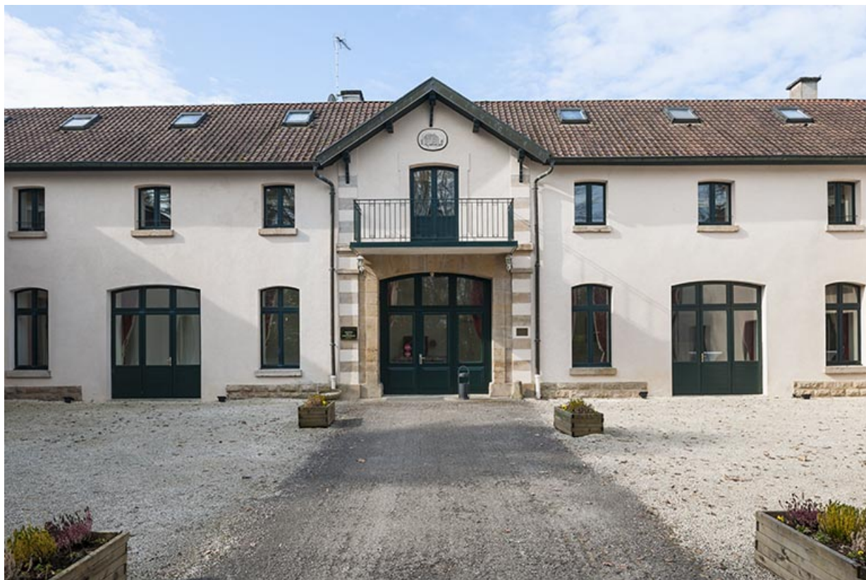
Bâtiment des communs. Travée centrale. 25, Geneuille route des Papetiers
