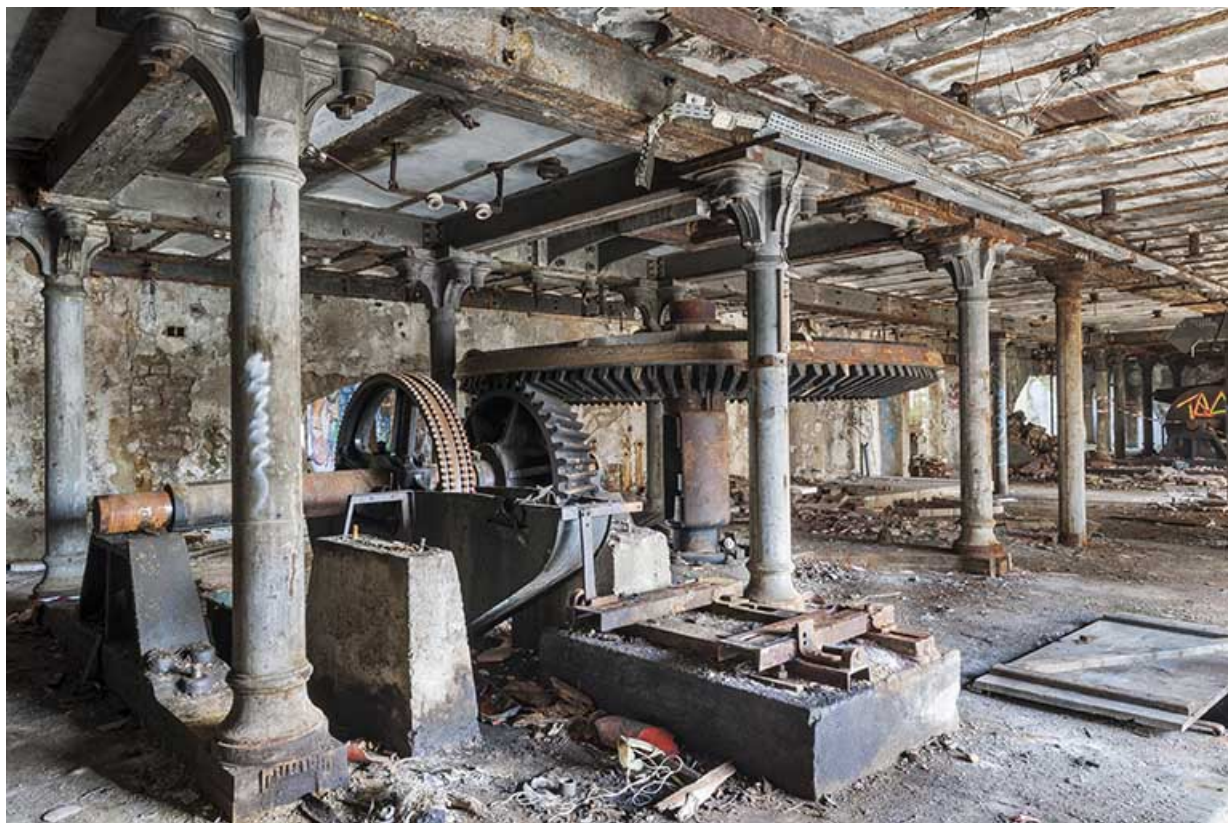
Rez-de-chaussée de l'atelier principal. Système de transmission de la turbine. 25, Geneuille route des Papetiers
