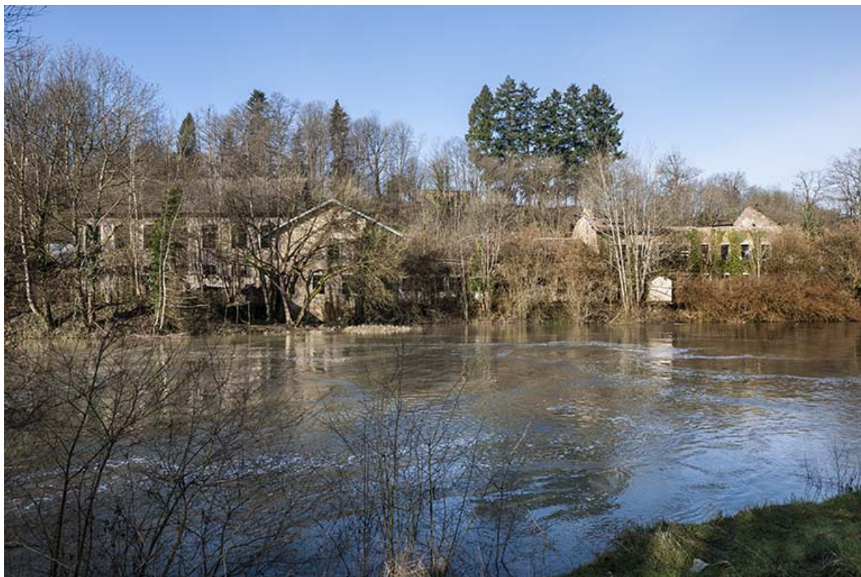
Vue d'ensemble depuis la rive droite.
