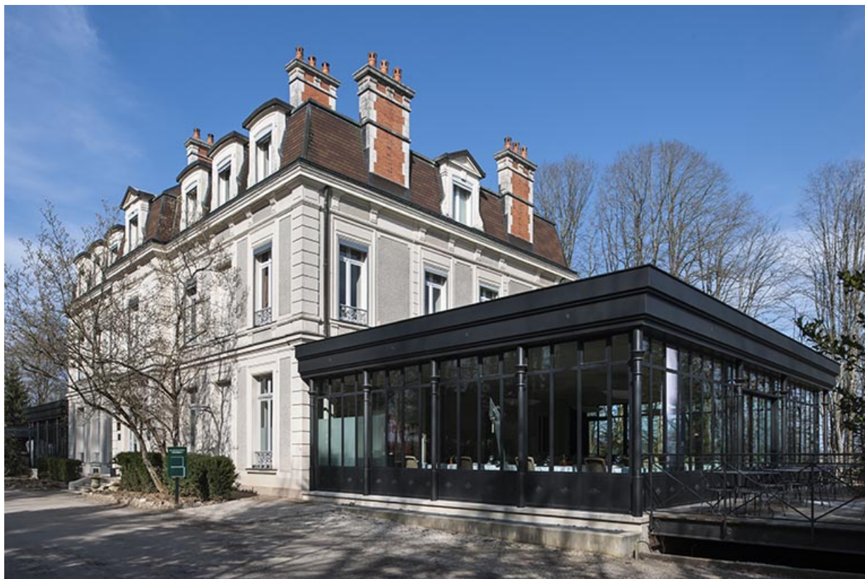
Logement patronal. Vue depuis le sud-est.
