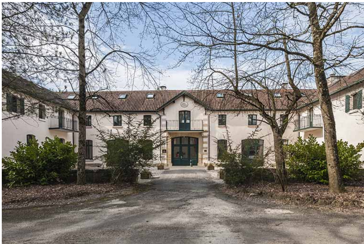
Bâtiment des communs. Vue axiale.
