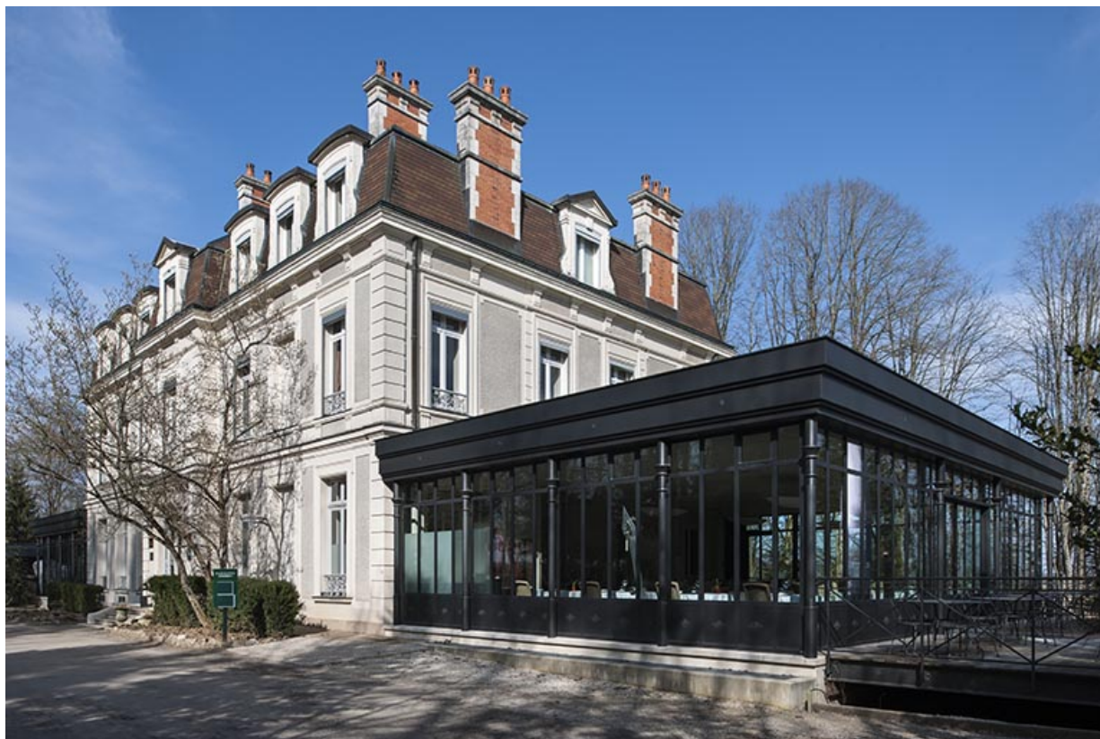
Logement patronal. Vue depuis le sud-est.
