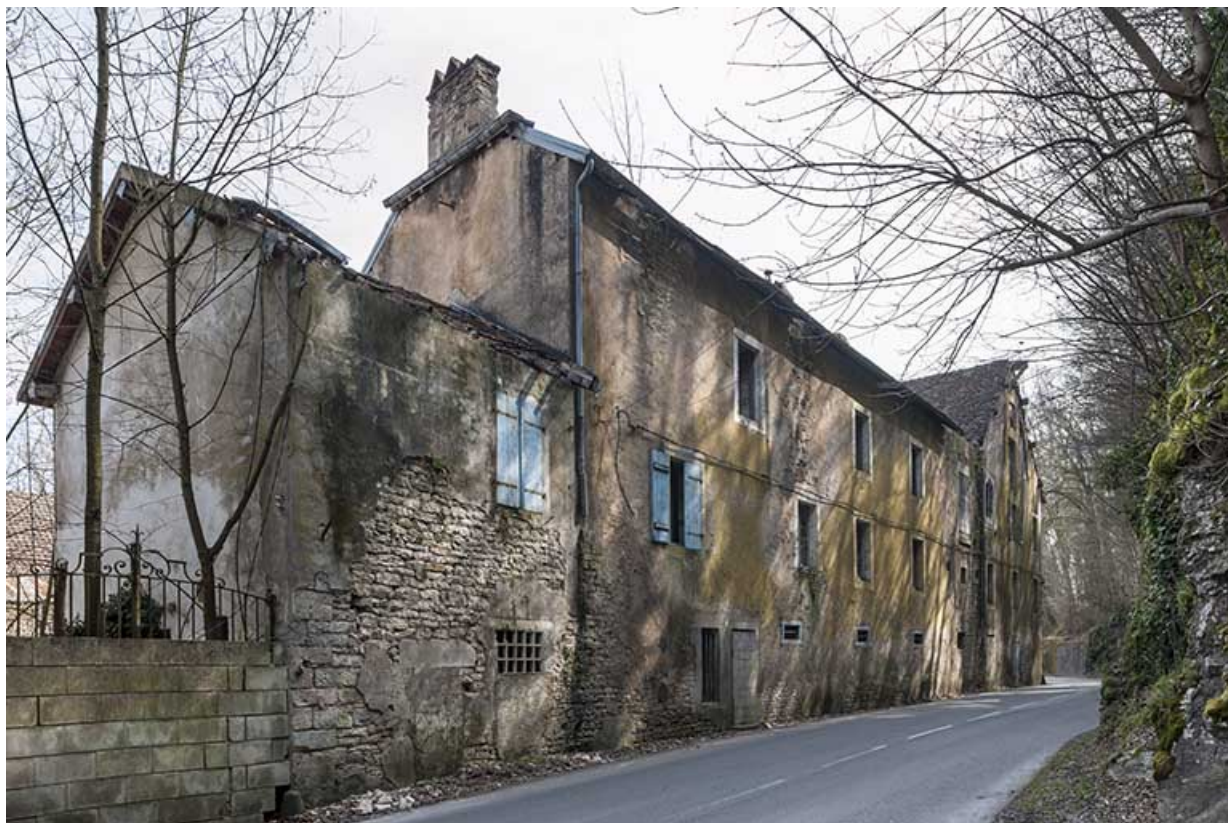
Bâtiment d'entrée longeant la route (logements).
