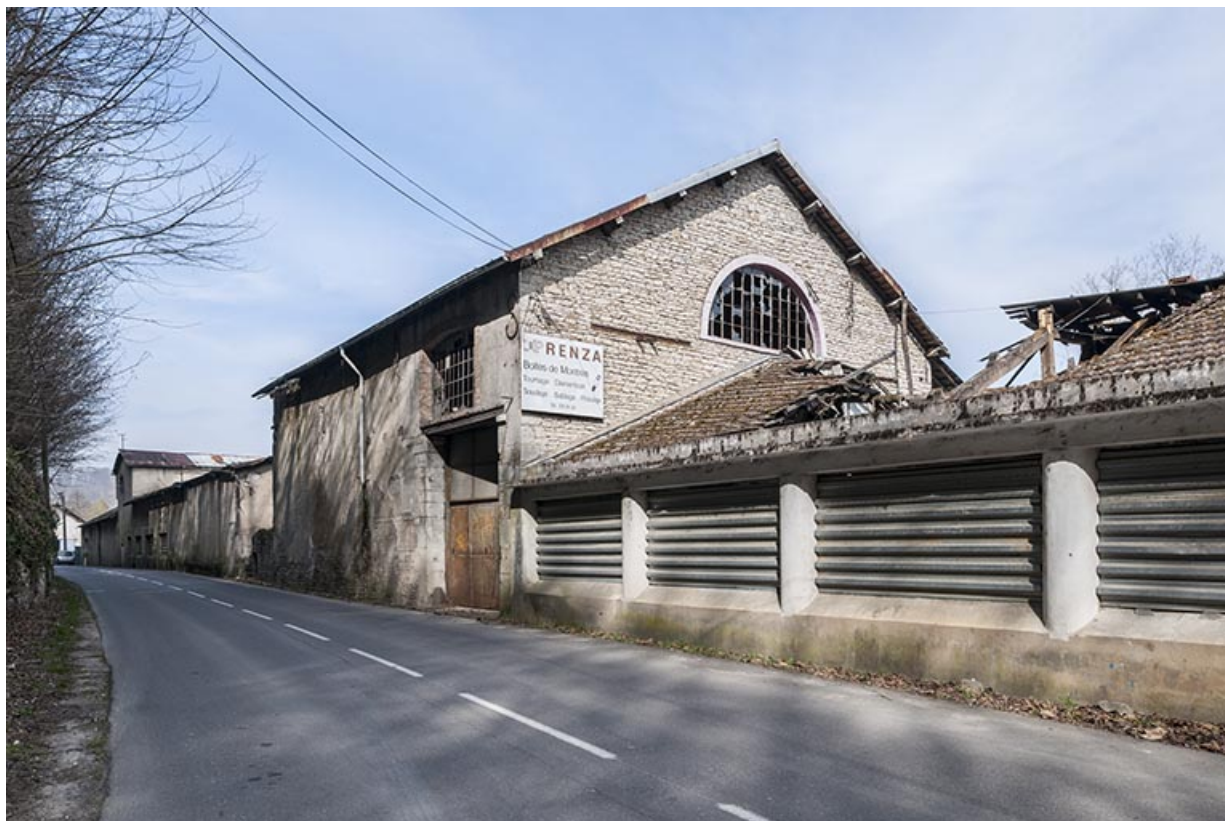
Route des Papetiers : chaufferie et magasin industriel.
