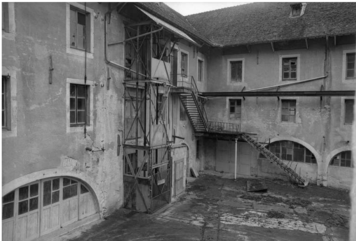
Le revers de l'ancien moulin (D) contenant la turbine.
