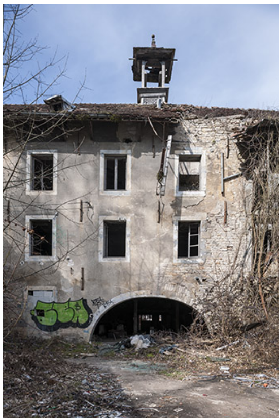
Façade sud de l'atelier principal.
