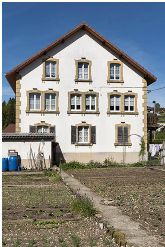
Façade latérale droite.
