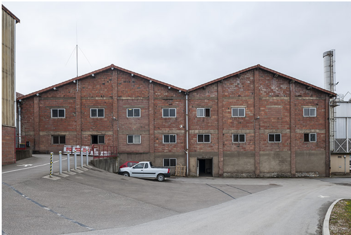
Murs-pignons de l'atelier de fabrication (actuellement UL 3). 25, Lantenne-Vertière route de Mercey
