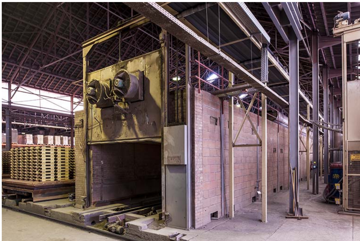
Unité de fabrication dite UL 1. Four désaffecté (années 1960 ?). 25, Lantenne-Vertière route de Mercey
