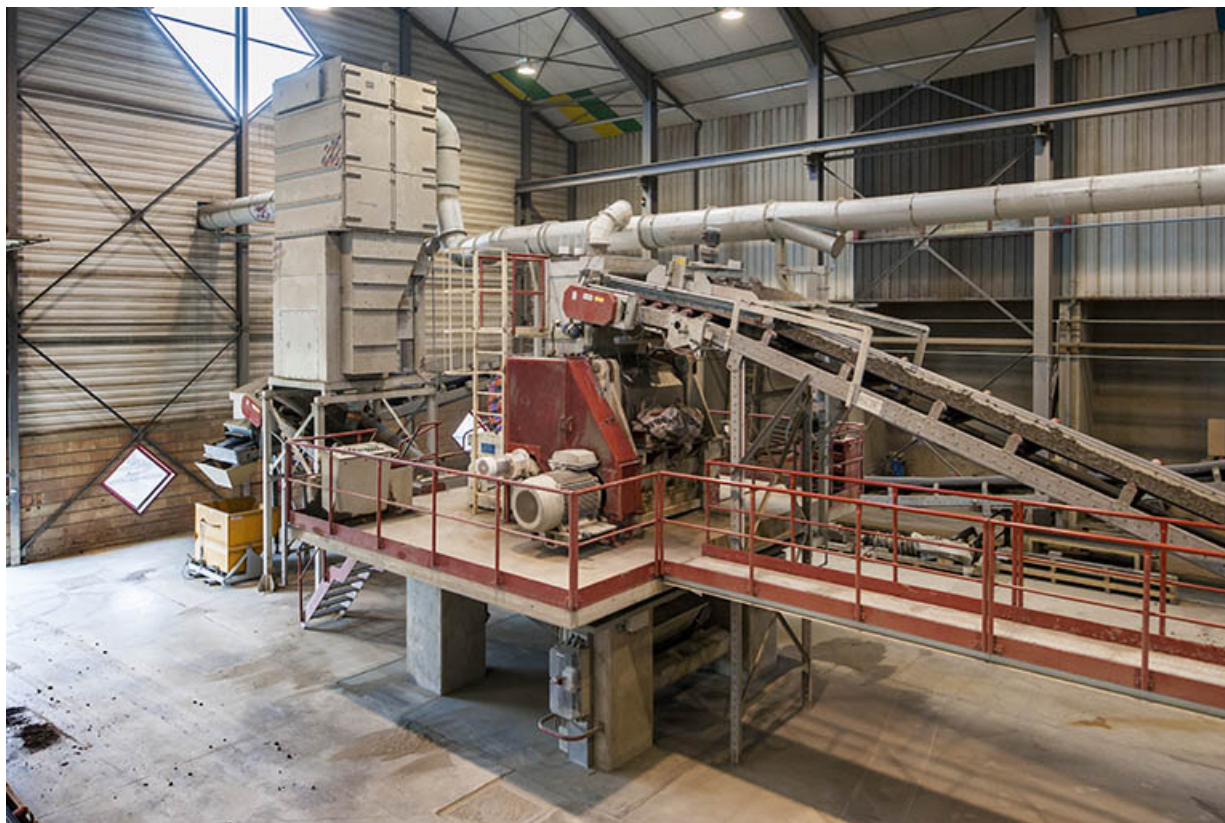
Unité de préparation des terres. Laminoir-finisher.
