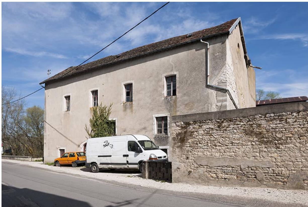
Façade sud de la minoterie.
