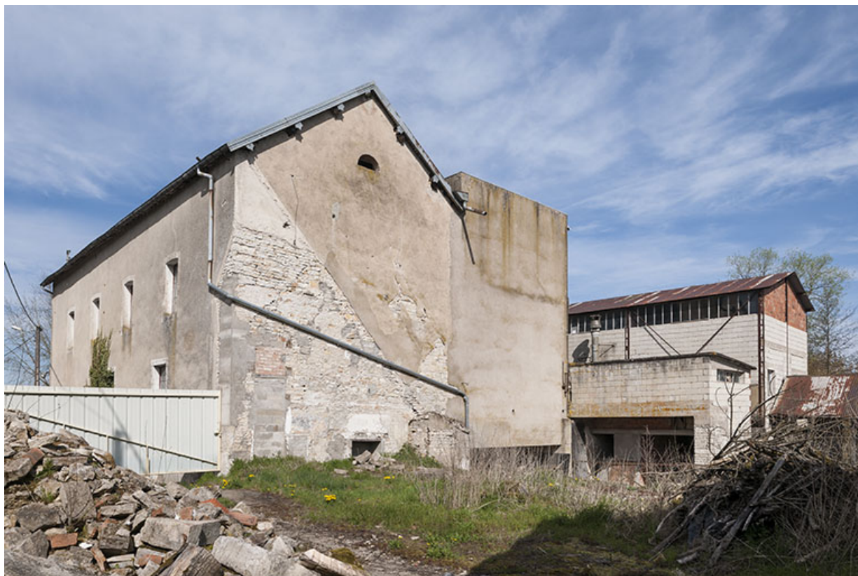
Minoterie (à gauche) et bâtiments industriels à droite.
