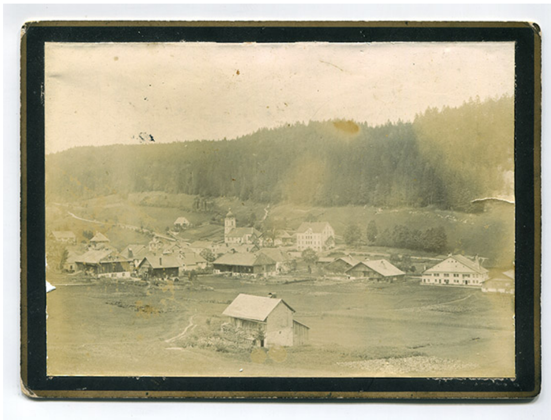
[Vue d'ensemble du village, depuis la route de La Brévine, à l'est], limite 19e siècle 20e siècle [avant 1910]. 25, Les Gras, 10-12 Grande Rue
