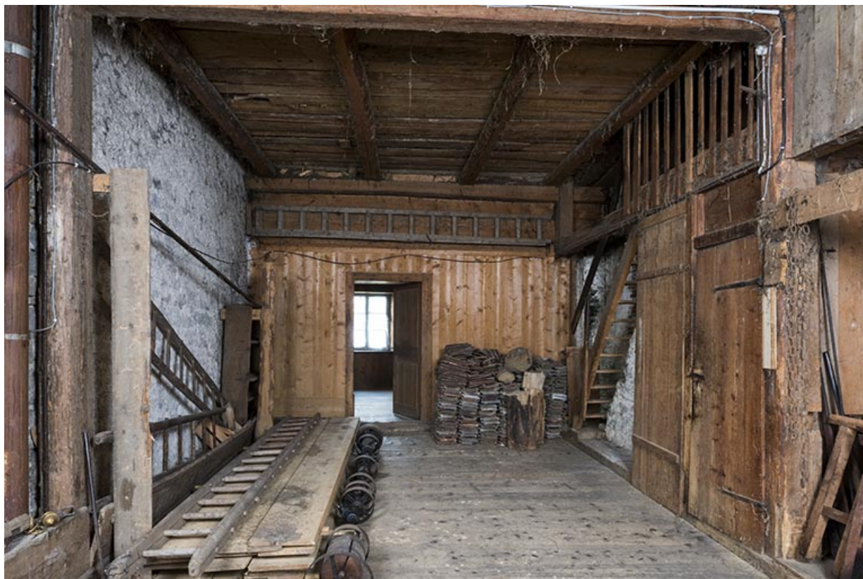
La grange, depuis l'entrée au nord. L'accès à l'atelier s'effectue par l'escalier en bois à droite. 25, Les Gras, 5 rue de Pontarlier
