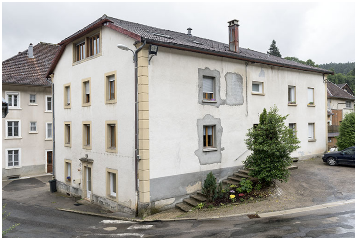
Façades antérieure et latérale droite.
