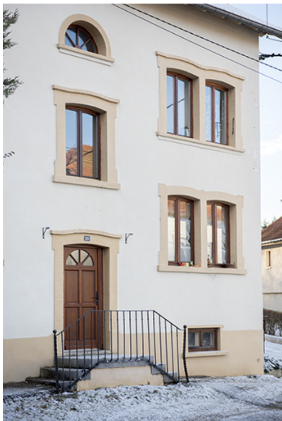
Façade antérieure : partie droite.
