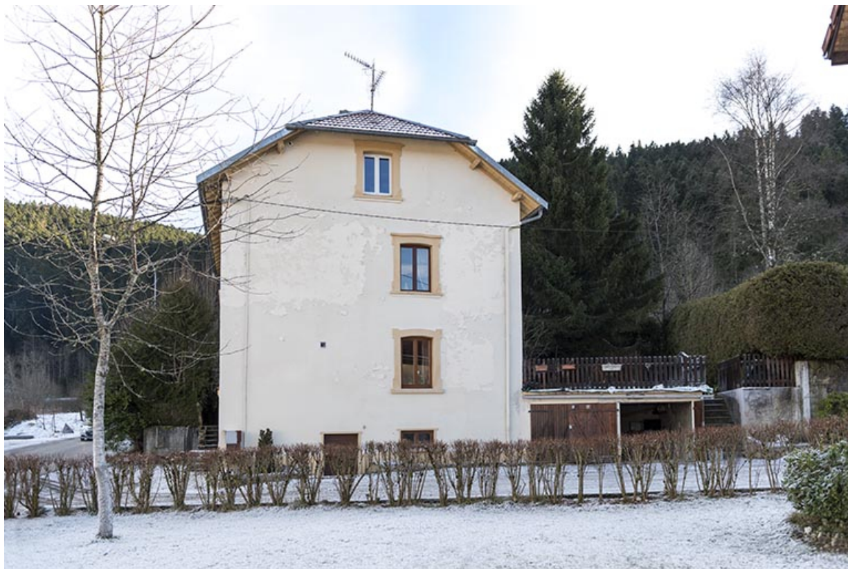
Façade latérale droite.
