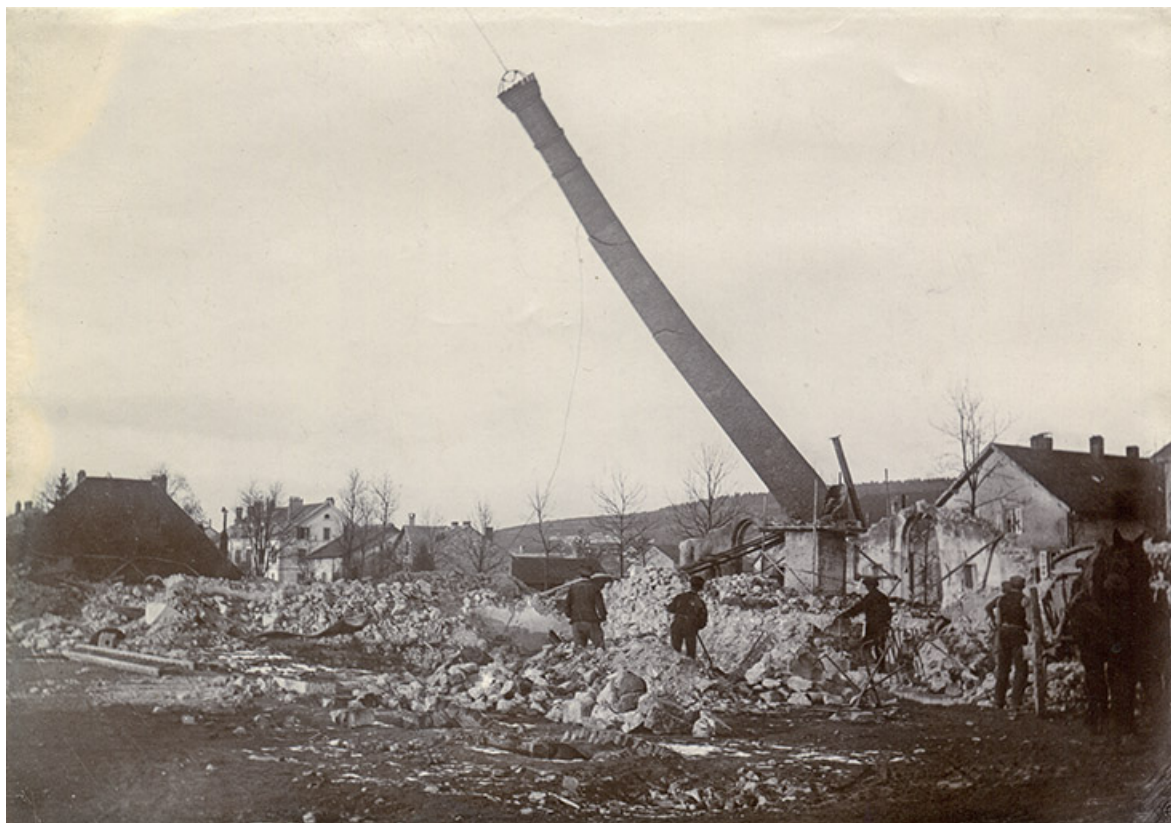
Démolition d'une cheminée suite à l'incendie du 11 août 1901, fotogr., s.d. [1901 ?].
