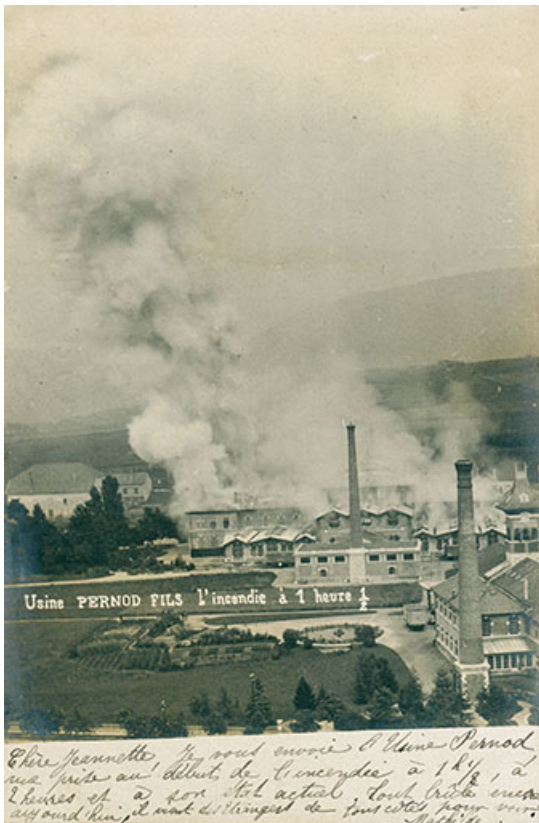
Usine Pernod Fils. Incendie du 11 août 1901. Incendie à 13H30, photographie. 25, Pontarlier, 2 avenue de l'Armée de l'Est
