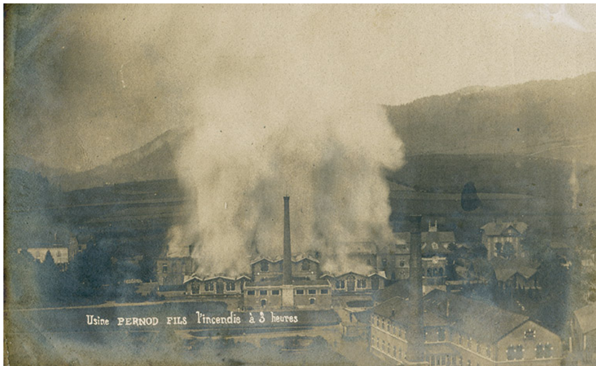
Usine Pernod Fils. Incendie du 11 août 1901. Incendie à 15H, photographie. 25, Pontarlier, 2 avenue de l'Armée de l'Est
