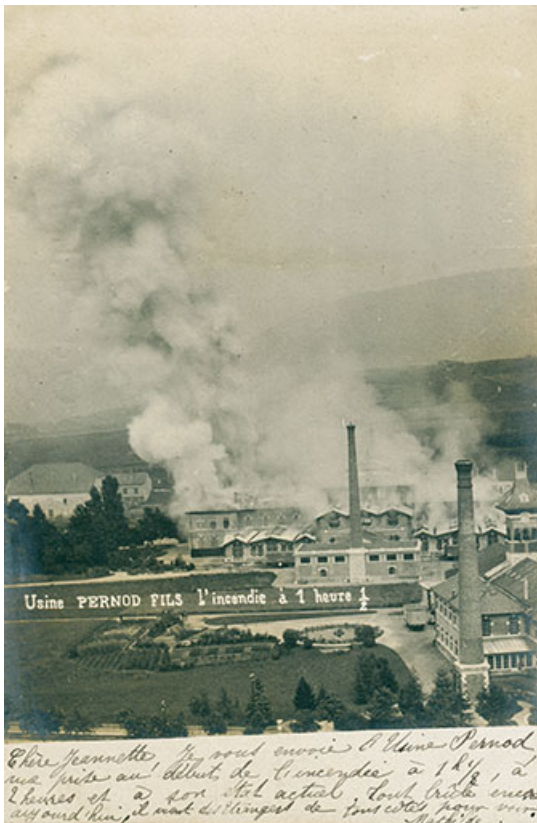
Usine Pernod Fils. Incendie du 11 août 1901. Incendie à 13H30, photographie. 25, Pontarlier, 2 avenue de l'Armée de l'Est
