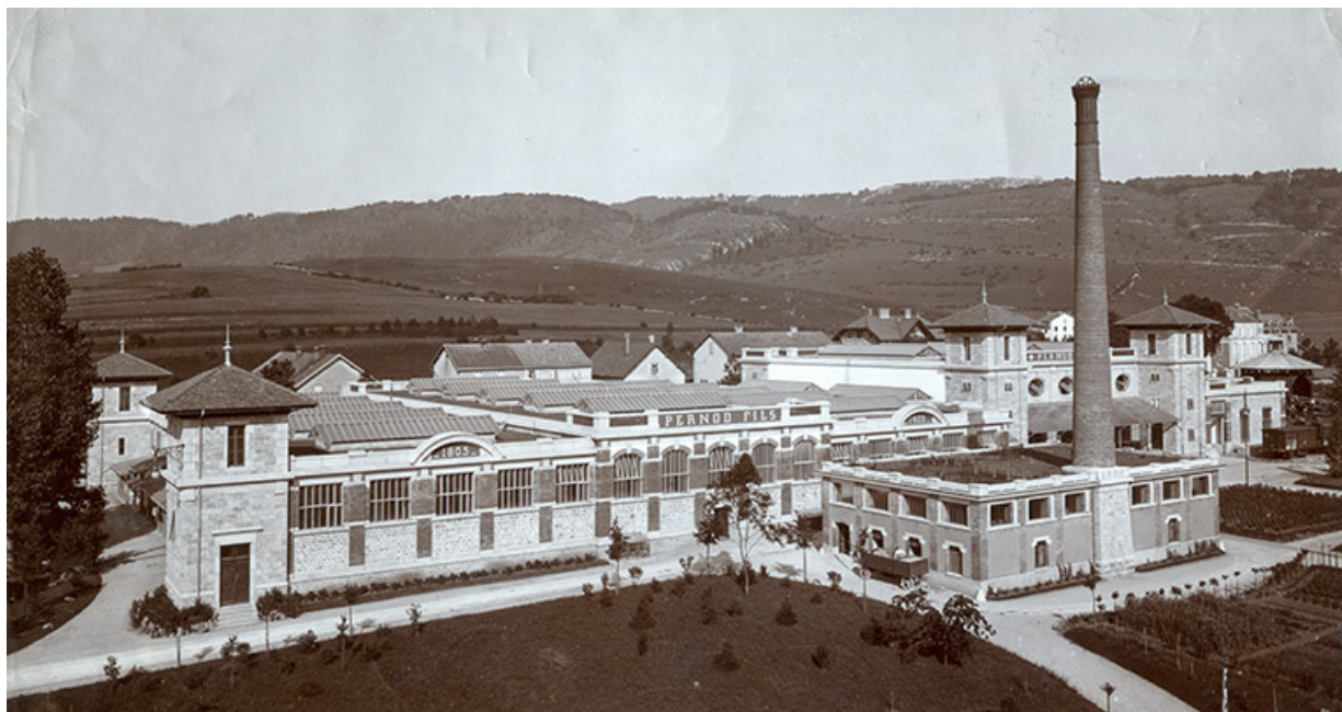
Vue d'ensemble de l'usine après reconstruction, fotogr., s.d. [1903 ?]. 25, Pontarlier, 2 avenue de l'Armée de l'Est
