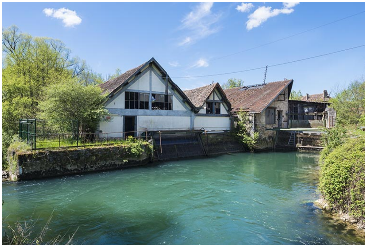
Pignons des ateliers de fabrication, au droit du canal d'amenée de la centrale hydroélectrique.
