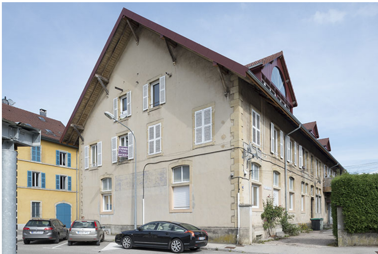
Vue d'ensemble depuis l'ouest.
