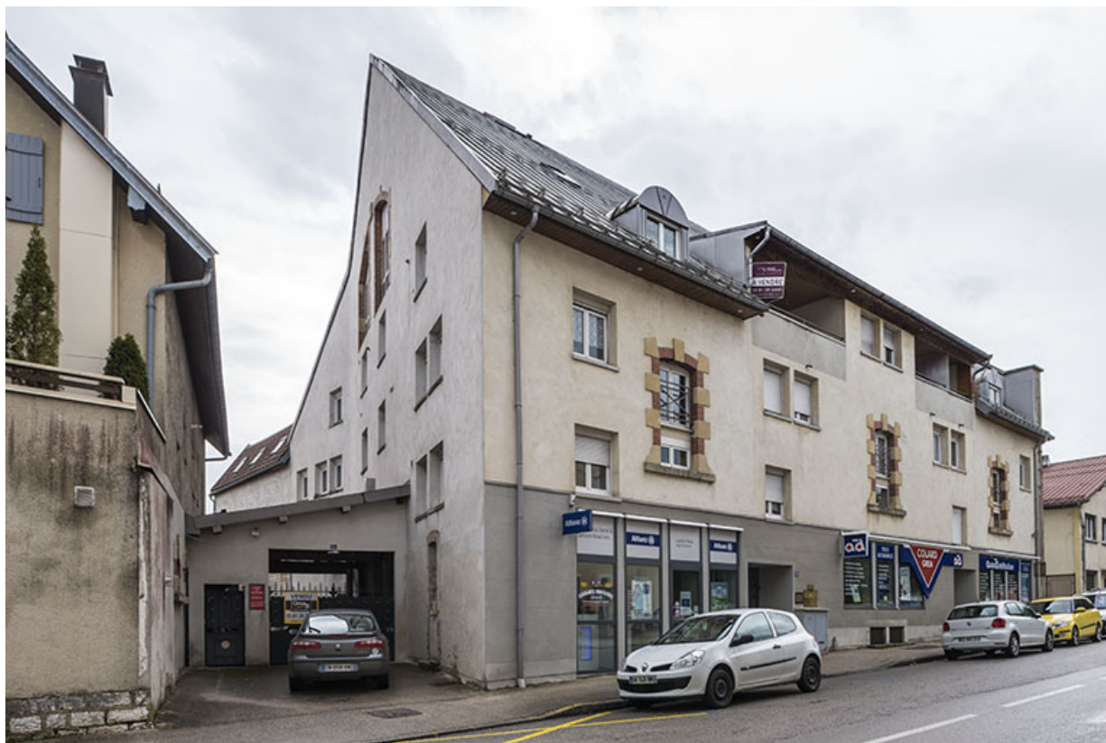
Chais (?). Vue de trois quarts gauche. 25, Pontarlier, 15 rue du docteur Grenier
