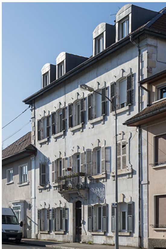
Logements et bureaux. Façade vue de trois quarts droite.
