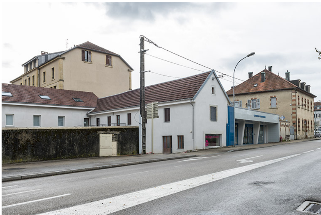
Vue d'ensemble depuis la rue du Mont.
