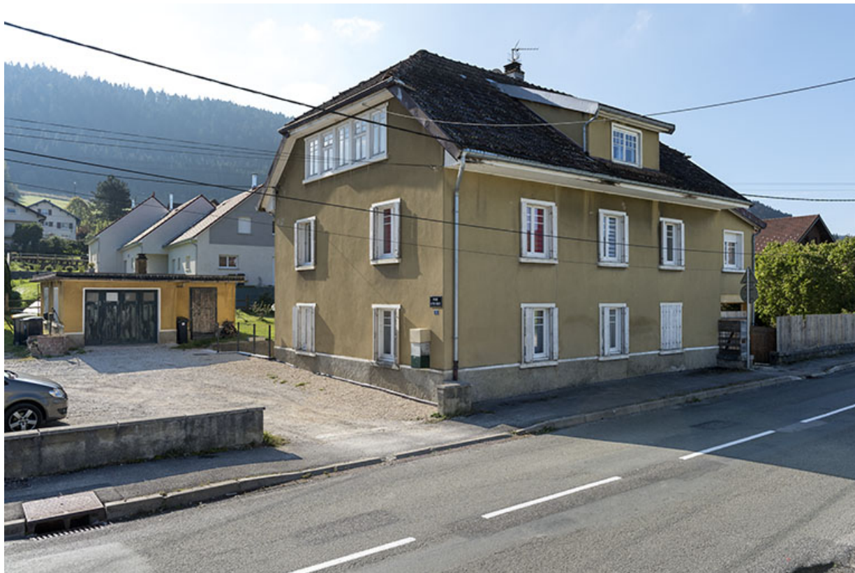
Façades antérieure et latérale gauche (garages à gauche). 25, Villers-le-Lac, 2 rue des Vieux Pargots, lieudit : les Pargots
