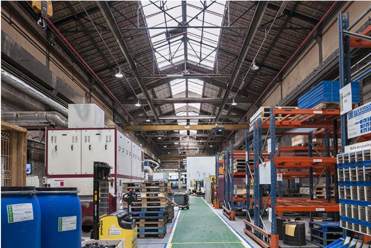
Atelier de tôlerie. Vue axiale de la charpente.
