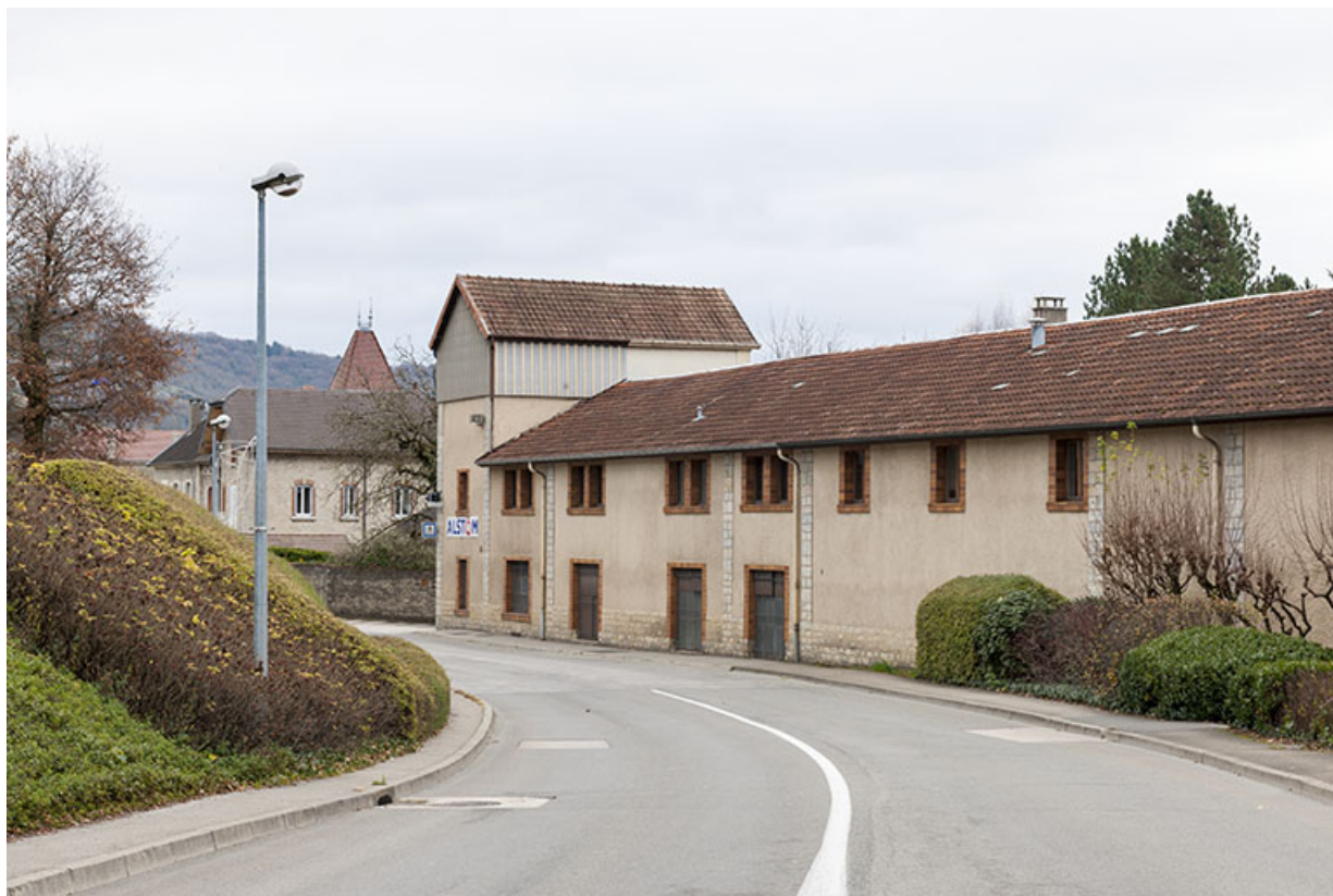
Bâtiments sur rue, abritant à l'origine la conciergerie, les bureaux et le magasin général.
