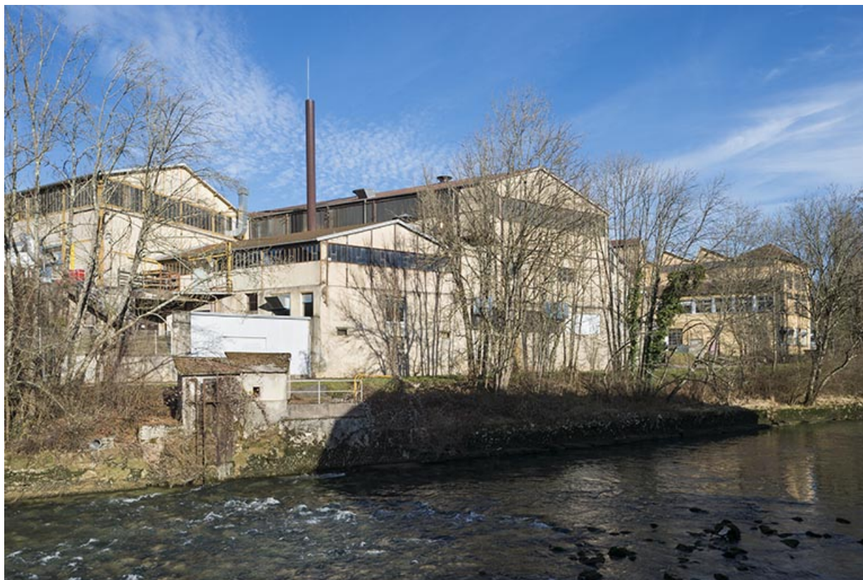
Façades sud de l'usine depuis la rive gauche de la Loue.
