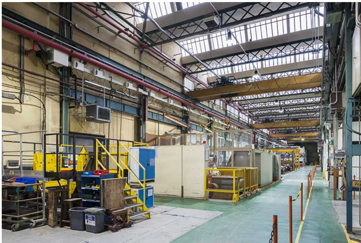
Hall central. Vue de côté.
