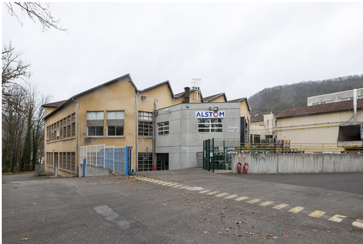
Partie sud de l'atelier principal depuis la rue du Miroir. 25, Ornans, 7 avenue du maréchal de Lattre de Tassigny
