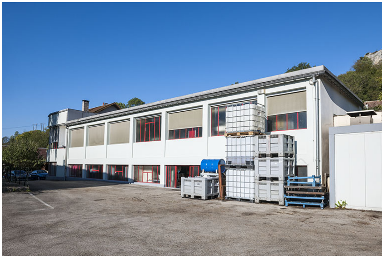
Façade est de l'atelier de fabrication.
