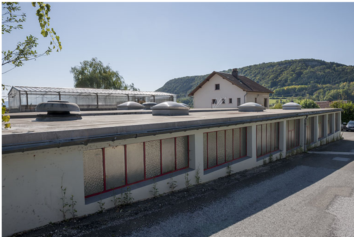
Façade sur rue de l'atelier de fabrication. 25, Ornans, 6 rue de la Garenne
