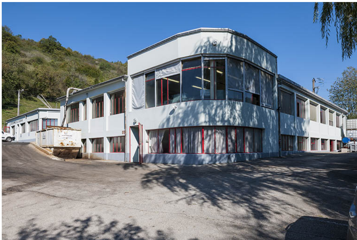
Atelier de fabrication vu depuis le sud.
