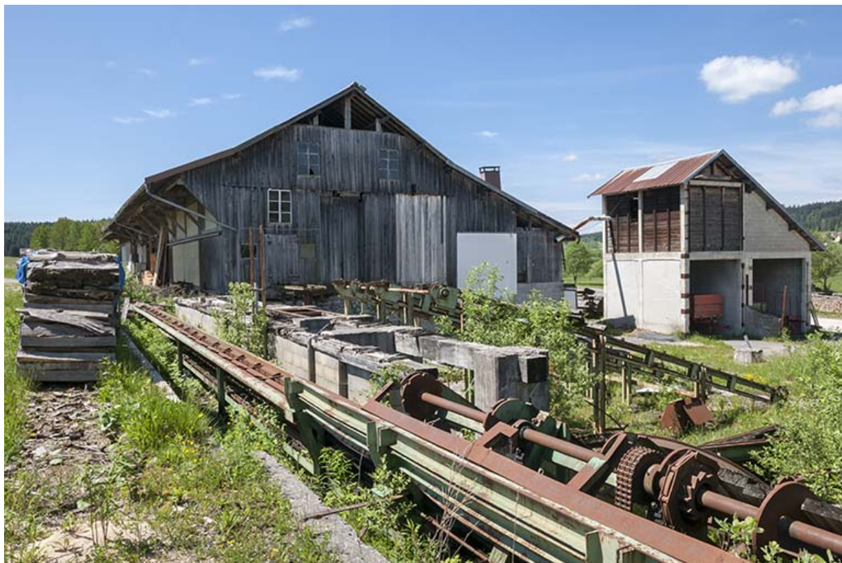
Pignon nord de l'ateiler de scierie et sciurier. 25, Vaux-et-Chantegrue, 3 Grande Route
