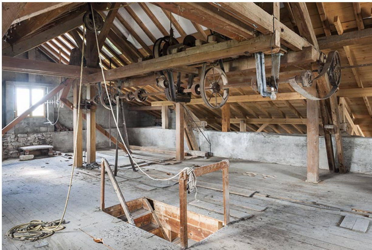
Etage en surcroît. Vue d'ensemble.
