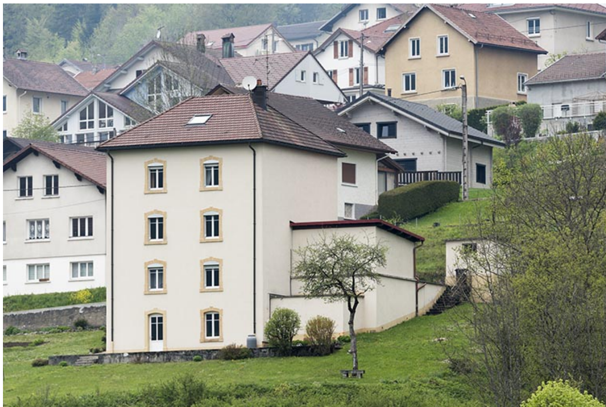
Façades postérieure et latérale gauche. 25, Villers-le-Lac, 24 rue du Quartier neuf
