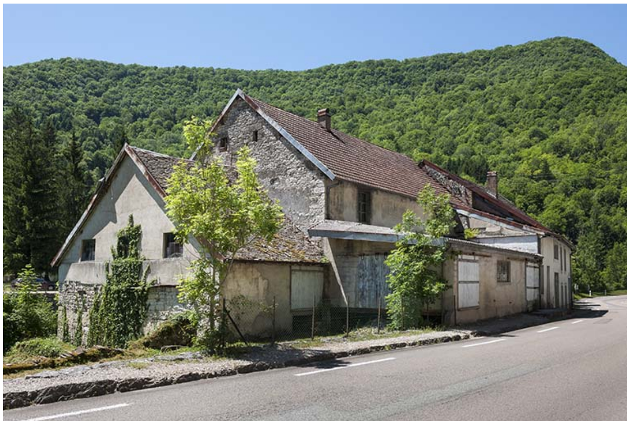
Vue de trois quarts, depuis la route départementale.
