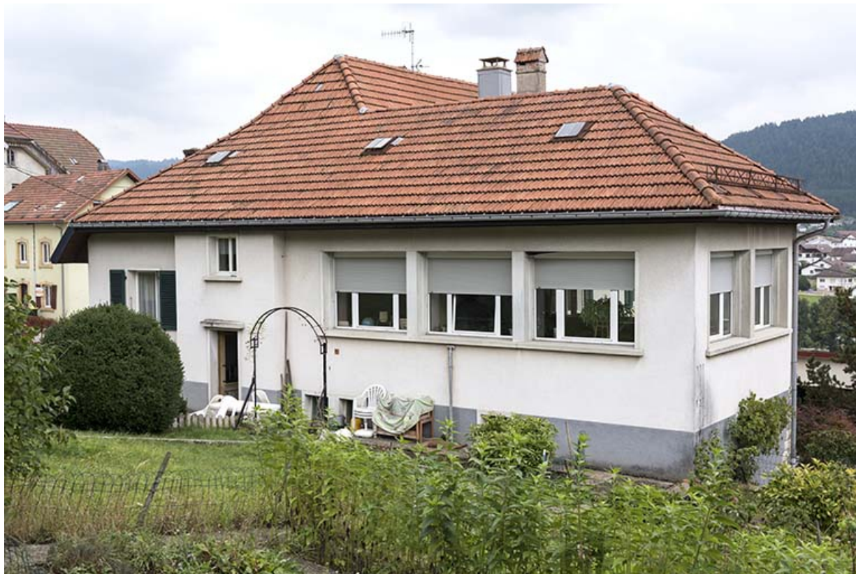
Façades postérieure et latérale gauche. 25, Villers-le-Lac, 21 rue du Quartier neuf
