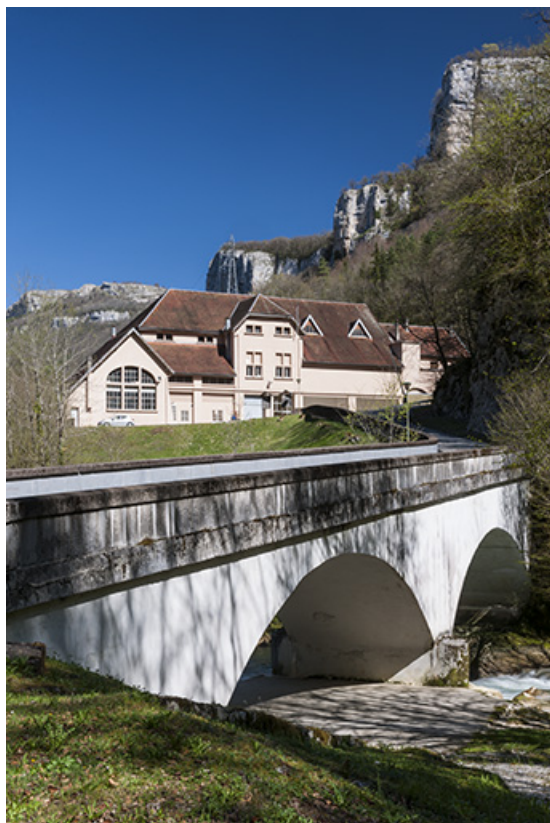
Vue du bâtiment d'exploitation depuis la centrale.
