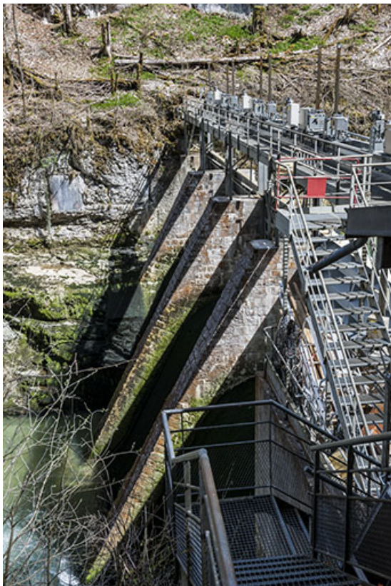
Détail des contreforts du barrage.
