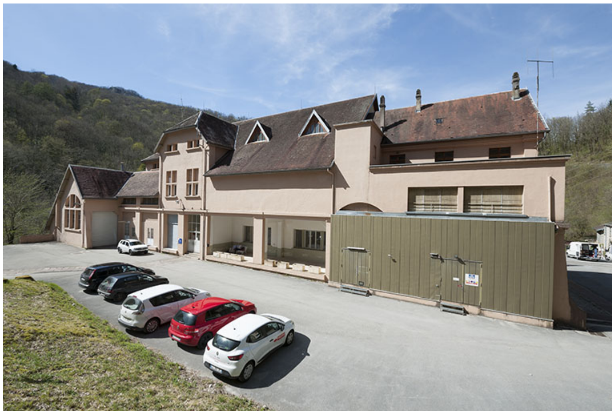
Le bâtiment d'exploitation vu de trois quarts droite.
