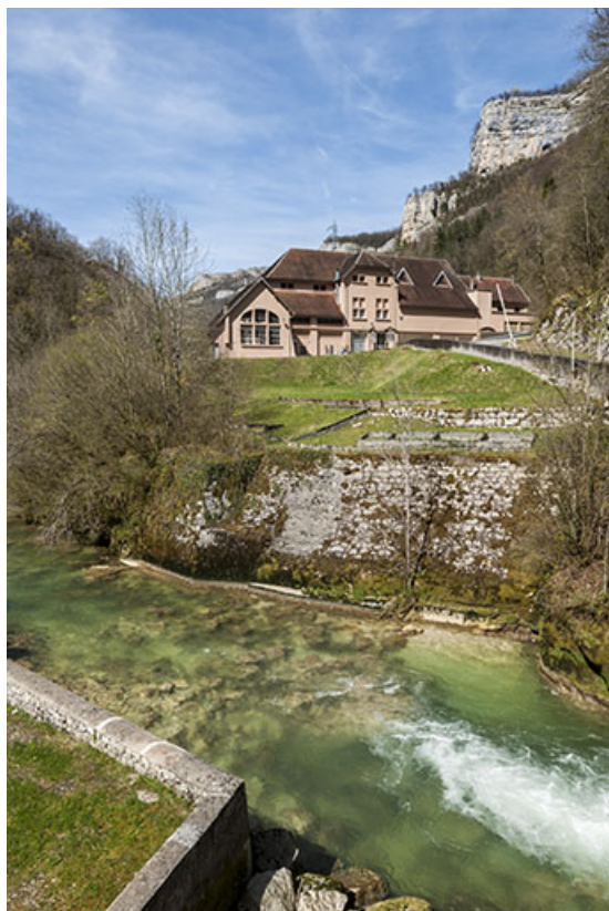
Le bâtiment d'exploitation depuis le sud.
