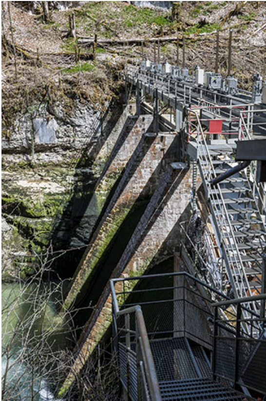
Détail des contreforts du barrage.
