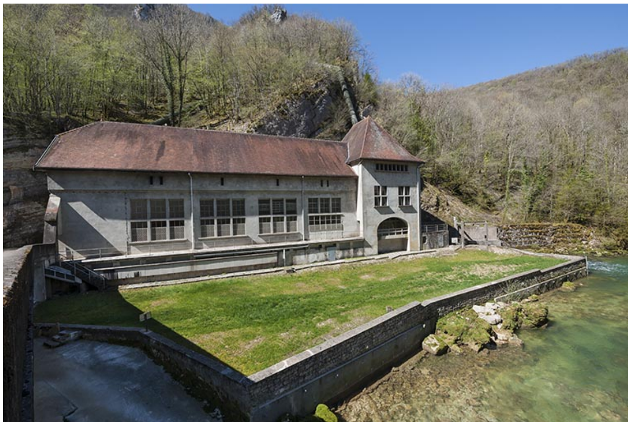
Vue de trois quarts gauche de la centrale.
