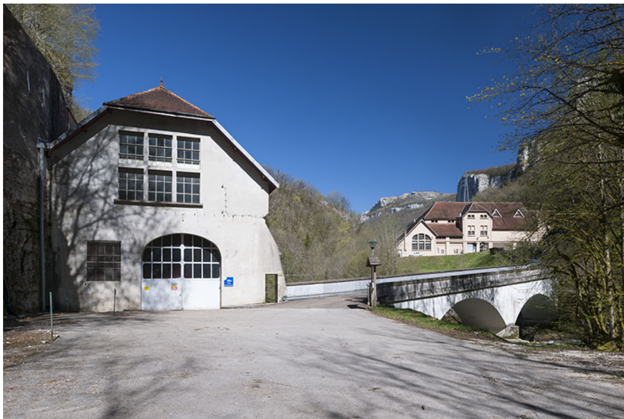
Centrale hydroélectrique et bâtiment d'exploitation depuis le sud.
