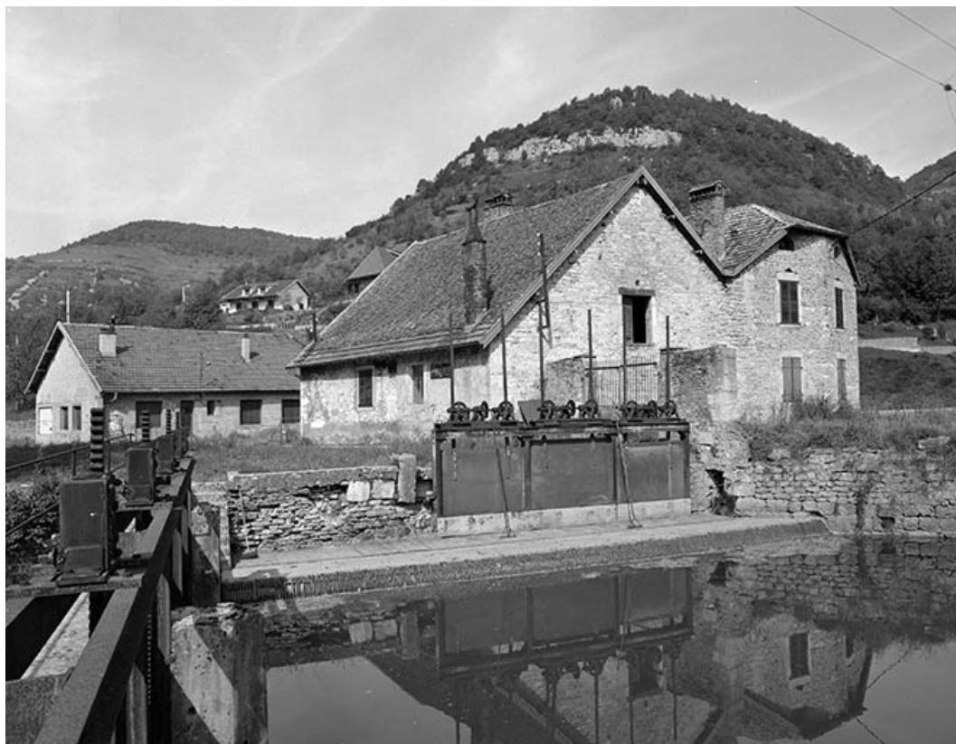
Vue d'ensemble des bâtiments de la tréfilerie Bersaillin.
