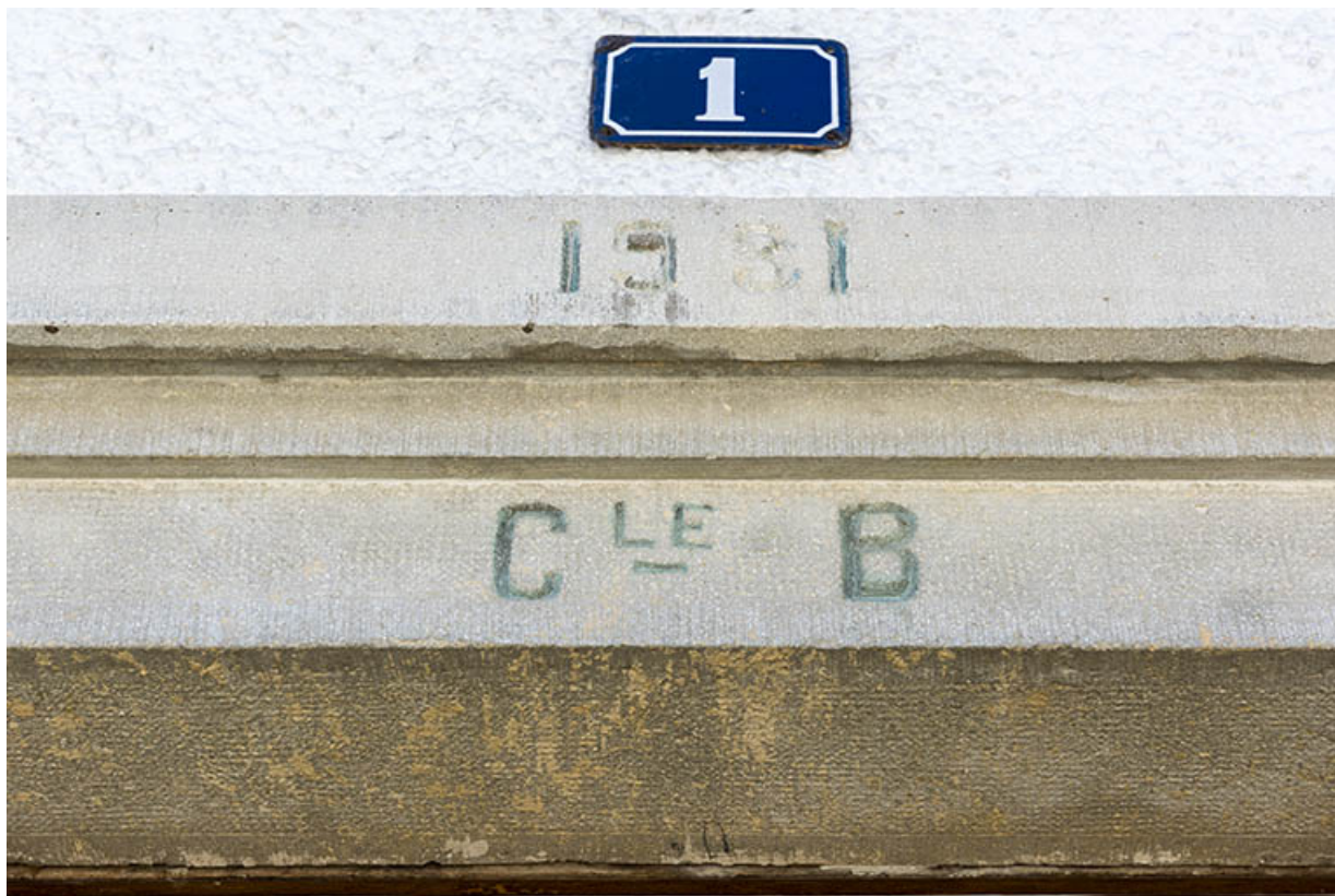
Maison : date et initiales sur le linteau de la porte de la façade latérale gauche. 25, Villers-le-Lac, 1 et 9 rue Newton
