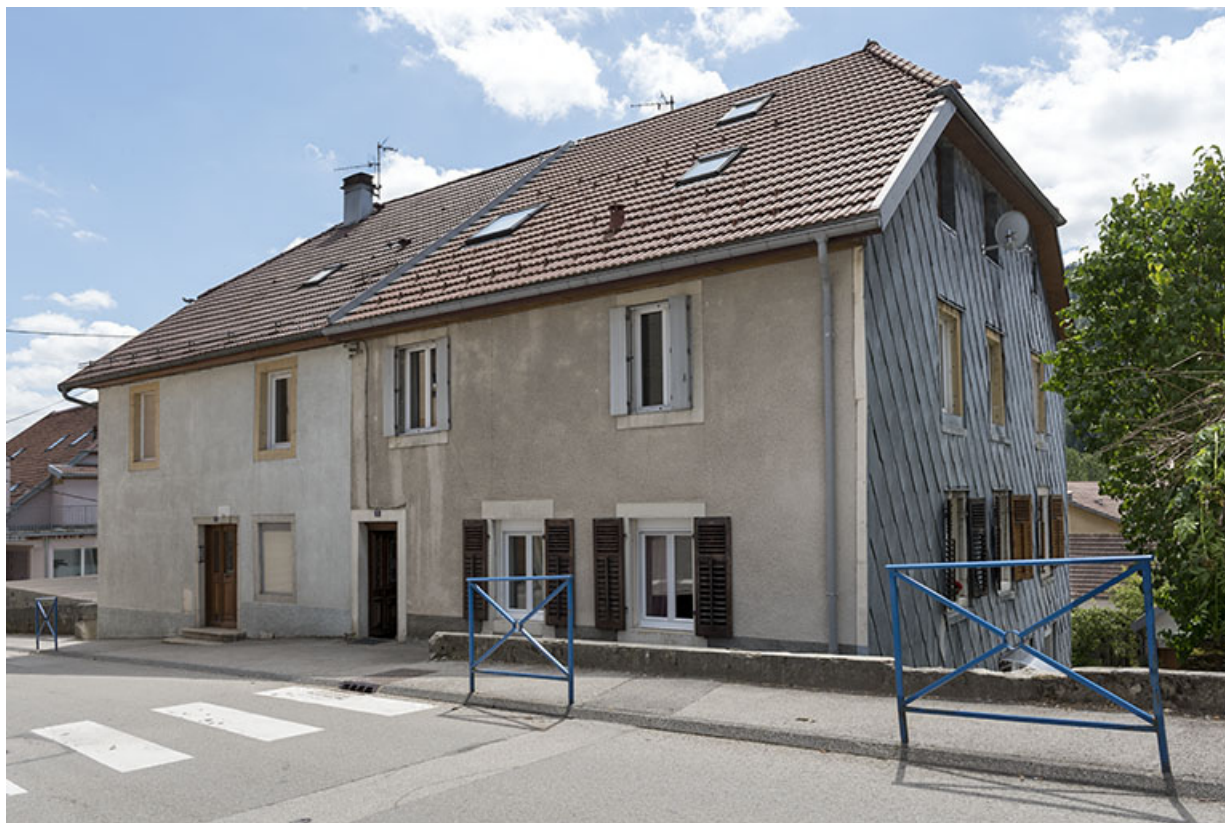
Façades antérieure et latérale droite.
