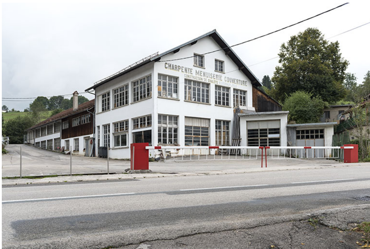
Site d'origine : façades antérieure et latérale gauche de l'atelier de fabrication nord. 25, Villers-le-Lac rue Pierre Berçot, lieudit : les Terres rouges
