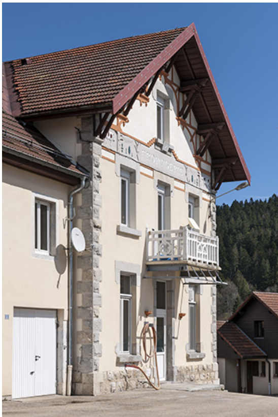
Pignon du logement vu de trois quarts droite.
