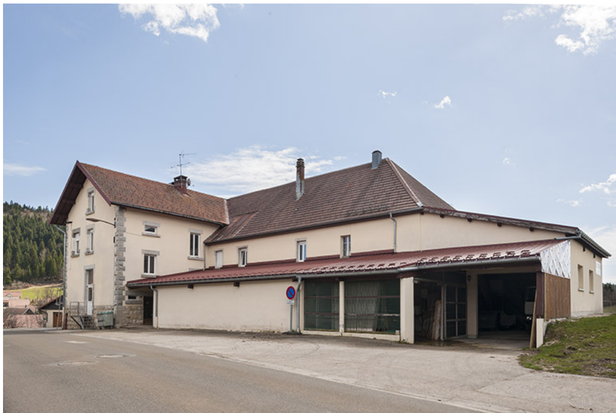
Vue depuis le nord. Extension des caves de pré-affinage.
