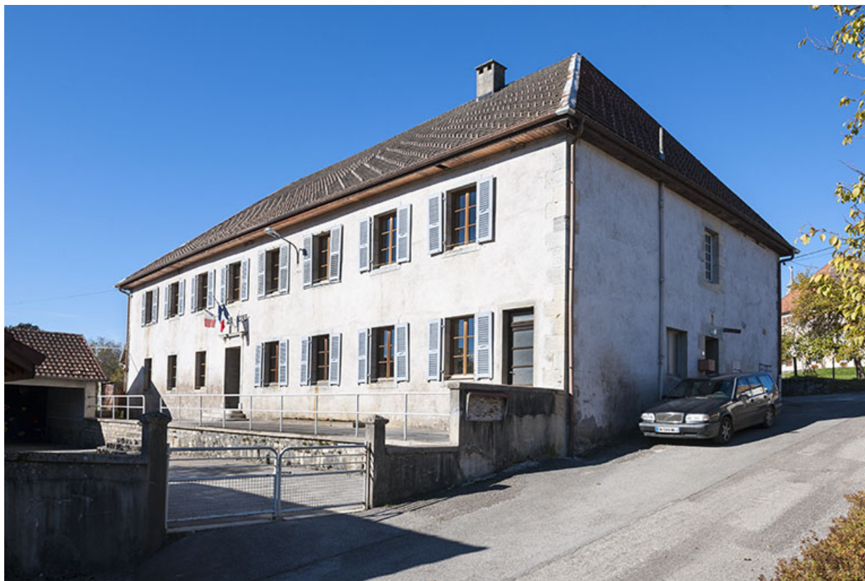
Vue d'ensemble depuis l'est. 25, Aubonne, 1 rue de la Mairie
