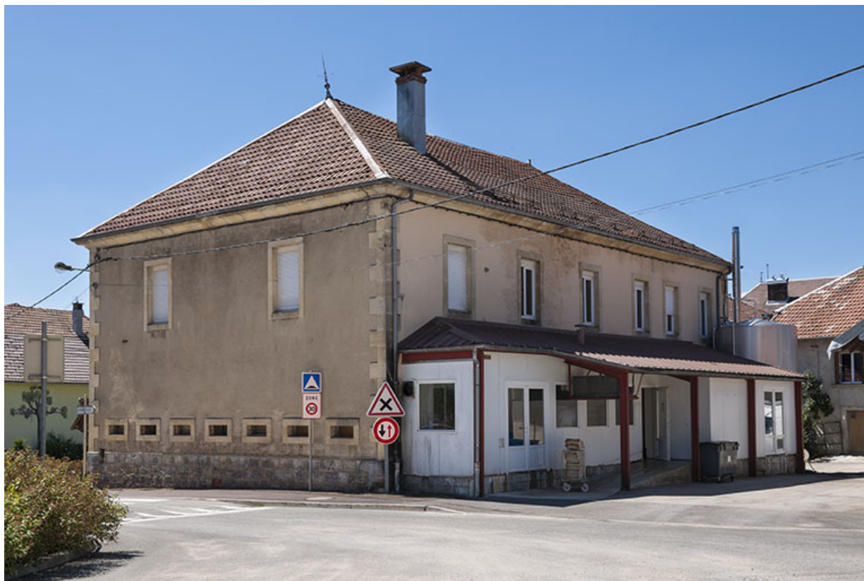
Vue de trois quarts arrière. 25, Évillers Grande Rue
