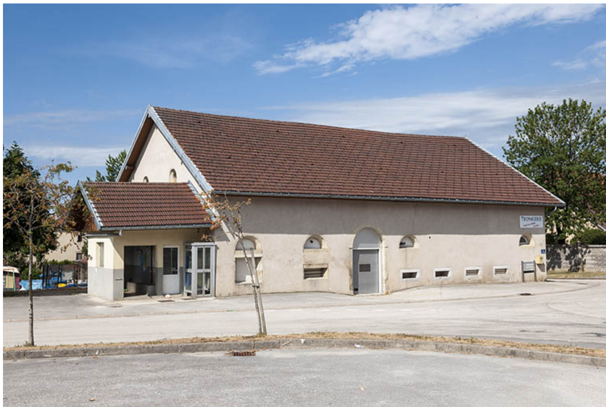
Façade nord en 2015.
