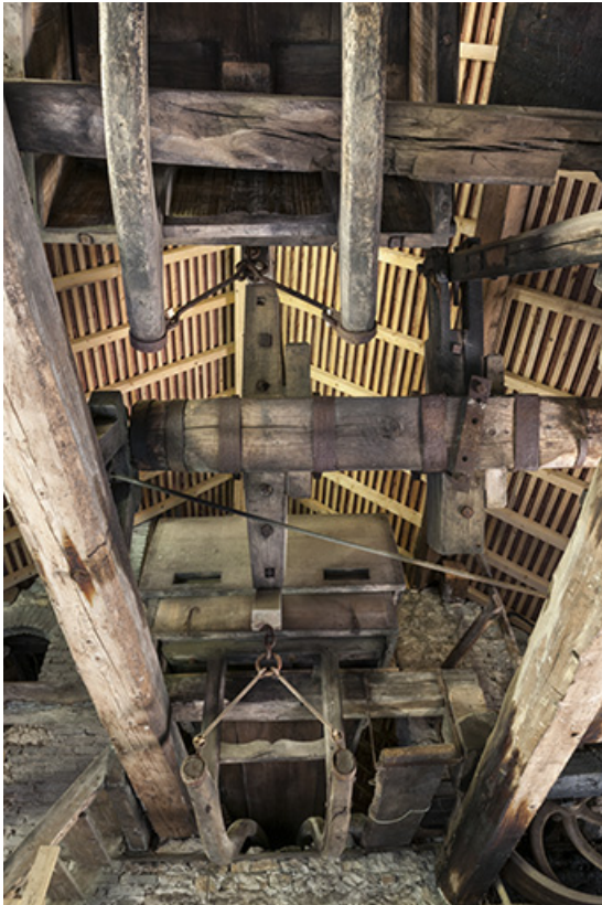
Mécanisme de bascule du soufflet double (caisson sud en position basse). 25, Nans-sous-Sainte-Anne rue du Four
