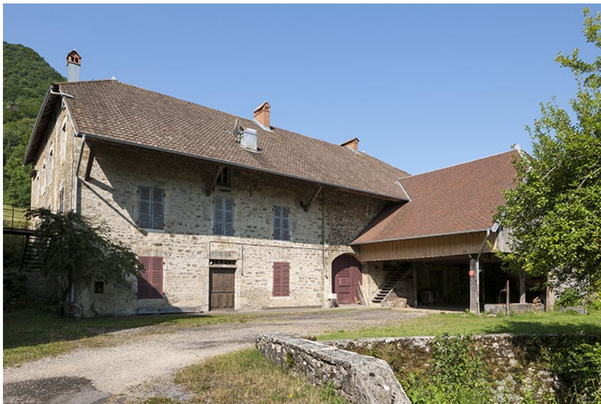
Logement et parties agricoles. Vue de trois quarts.
