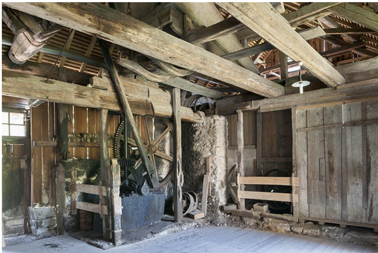
Pièce de la machine soufflante. En partie inférieure, système de transmission par bielle. 25, Nans-sous-Sainte-Anne rue du Four
