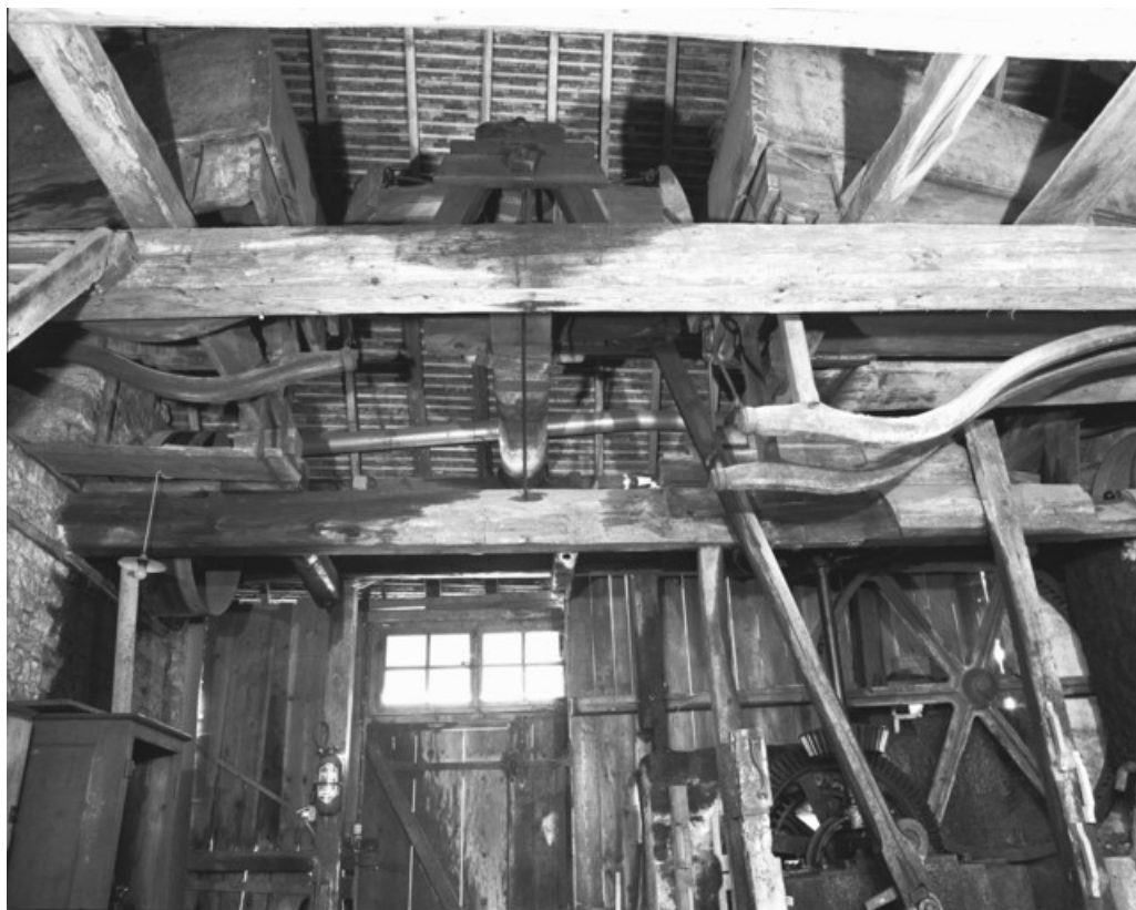
Vue des installations face à la porte d'entrée du local de soufflerie.
