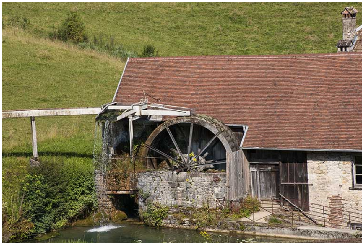
Roue hydraulique de la machine soufflante.
