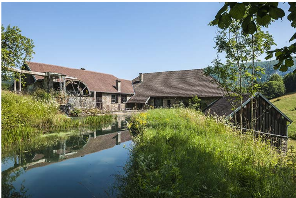
La taillanderie vue depuis le canal d'aménée. 25, Nans-sous-Sainte-Anne rue du Four
