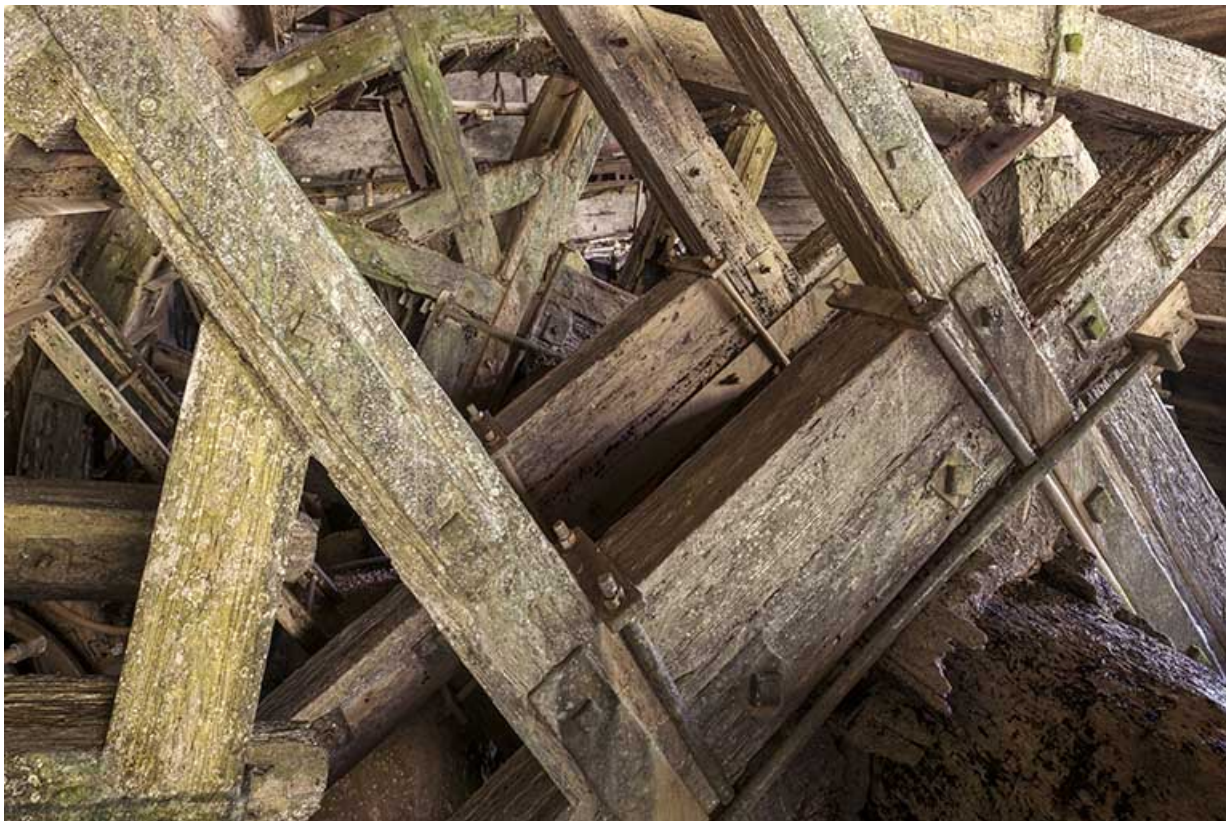
Détail des armatures en bois des roues hydrauliques.
