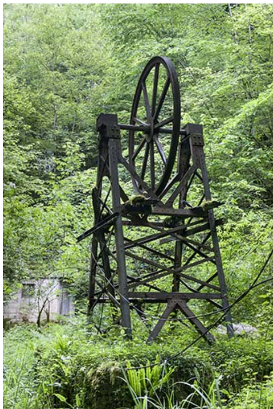
Support métallique (amont) de la transmission par câble. 25, Éternoz, 4 rue du Moulin
