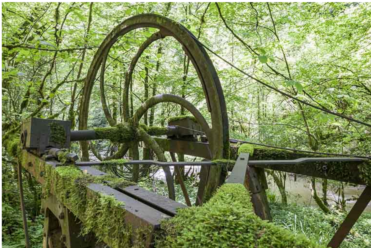
Poulie métallique à gorge du support aval.
