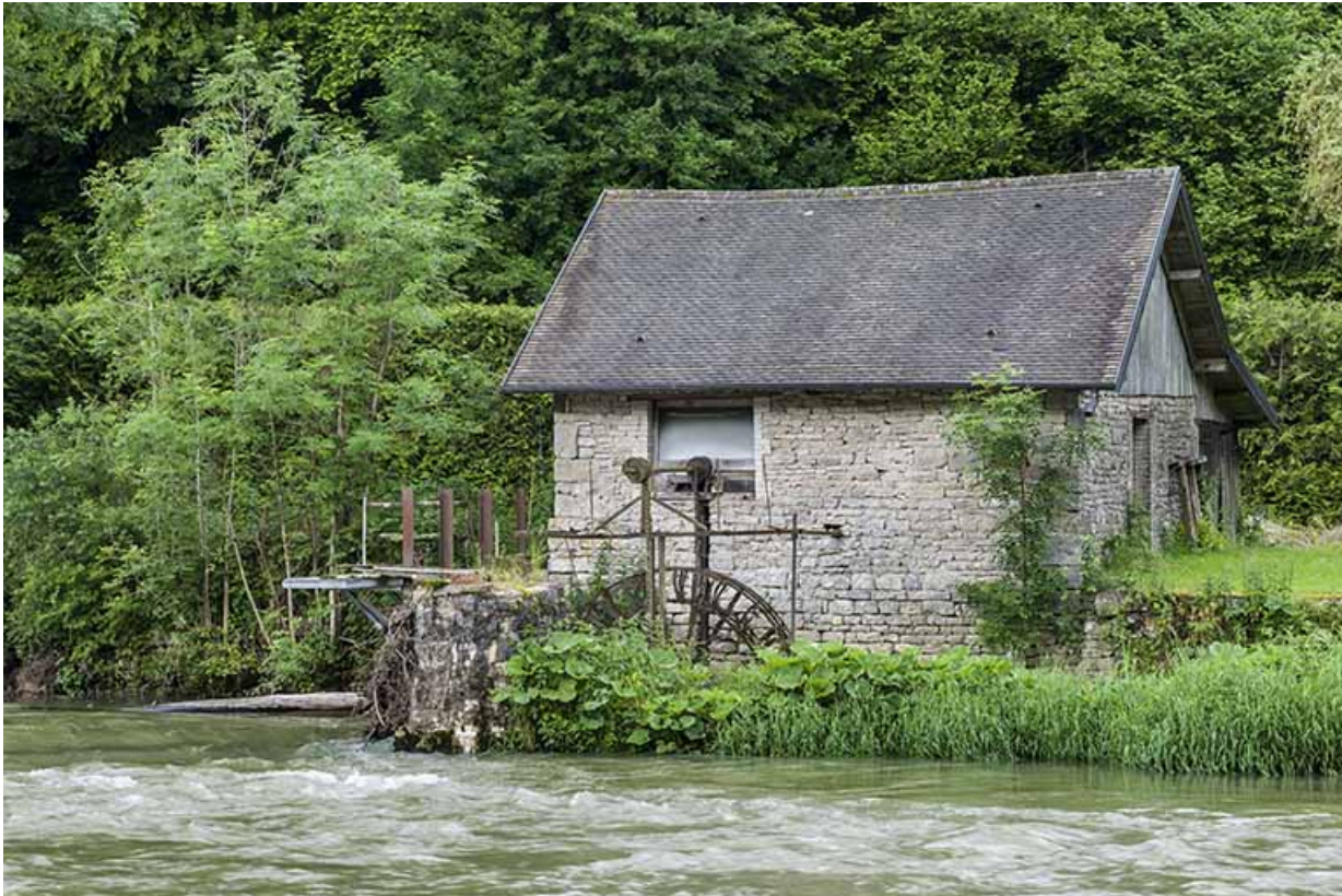
Façade est du bâtiment d'eau, et roue hydraulique pendante.
