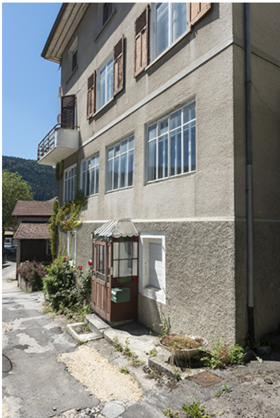
Façade antérieure (rue du Doubs), vue en enfilade : baies d'atelier. 25, Villers-le-Lac, 1 rue du Doubs
