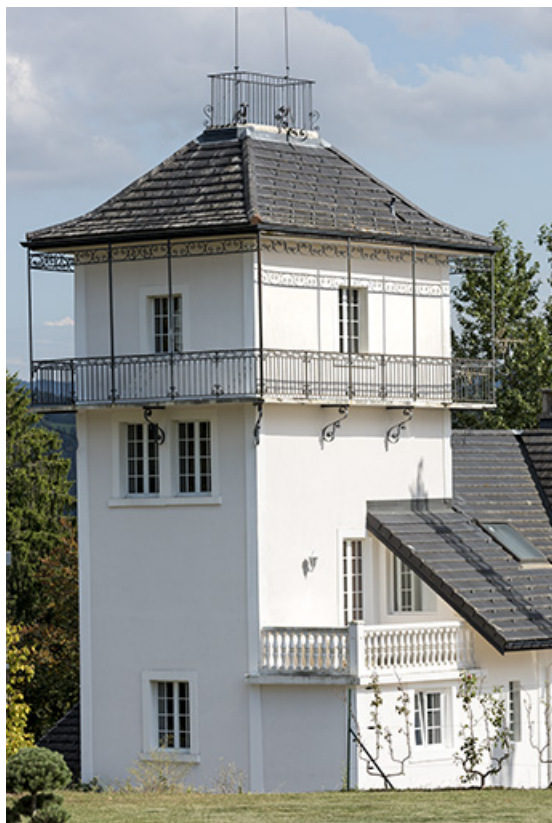
Tour, vue du nord-ouest.
