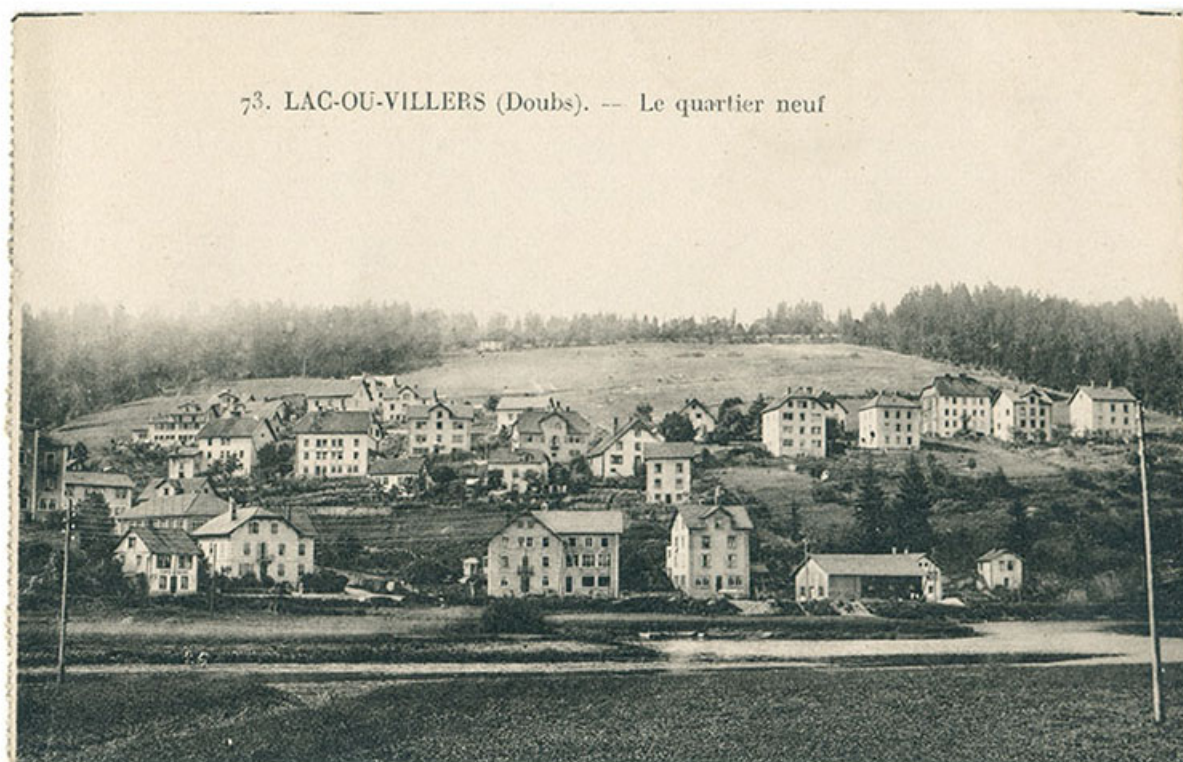
73. Lac-ou-Villers (Doubs). - Le quartier neuf [vu de l'est], 2e quart 20e siècle [vers 1925-1927]. Seul existe le premier bâtiment (au centre à gauche). 25, Villers-le-Lac
