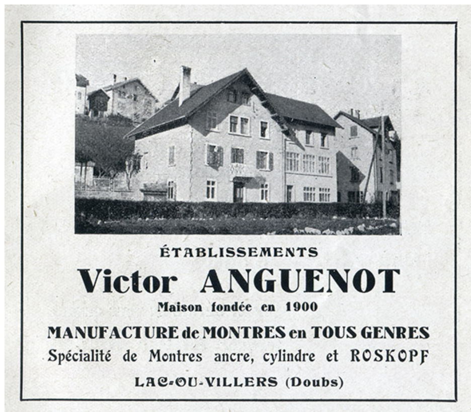
Etablissements Victor Anguenot [façade antérieure, de trois quarts gauche], 1943. 25, Villers-le-Lac, 7 rue du Lac
