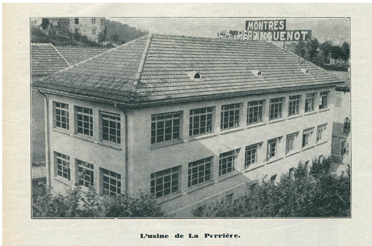
L'usine de La Perrière [vue plongeante, depuis le sud-ouest], 1933.
