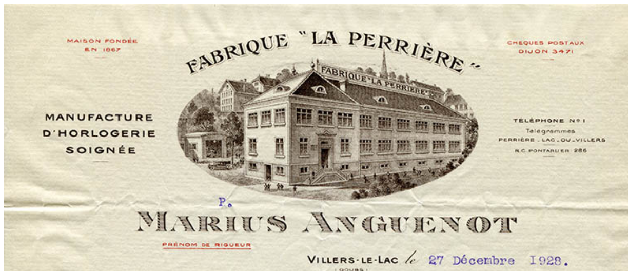
Fabrique "La Perrière" Marius Anguenot [détail montrant l'usine de trois quarts gauche], 27 décembre 1928 25, Villers-le-Lac, 1-3 B rue de la Perrière
