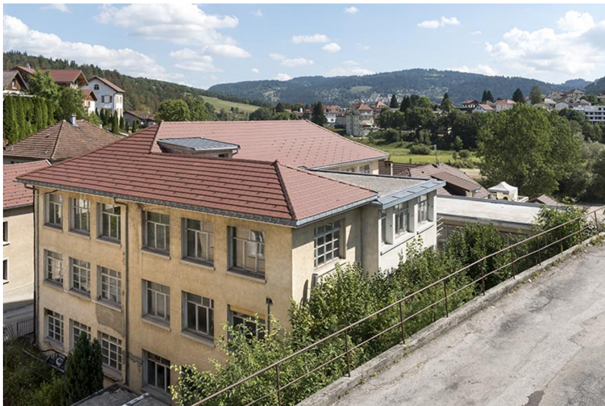
Usine : vue plongeante sur les façades postérieure et latérale droite. 25, Villers-le-Lac, 1-3 B rue de la Perrière
