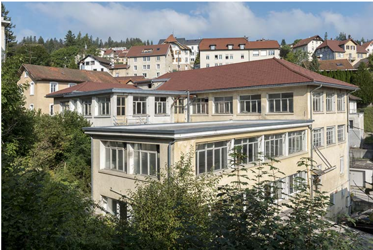
Usine : façade latérale gauche et corps bâti entre 1939 et 1951 en retour contre la façade postérieure. 25, Villers-le-Lac, 1-3 B rue de la Perrière
