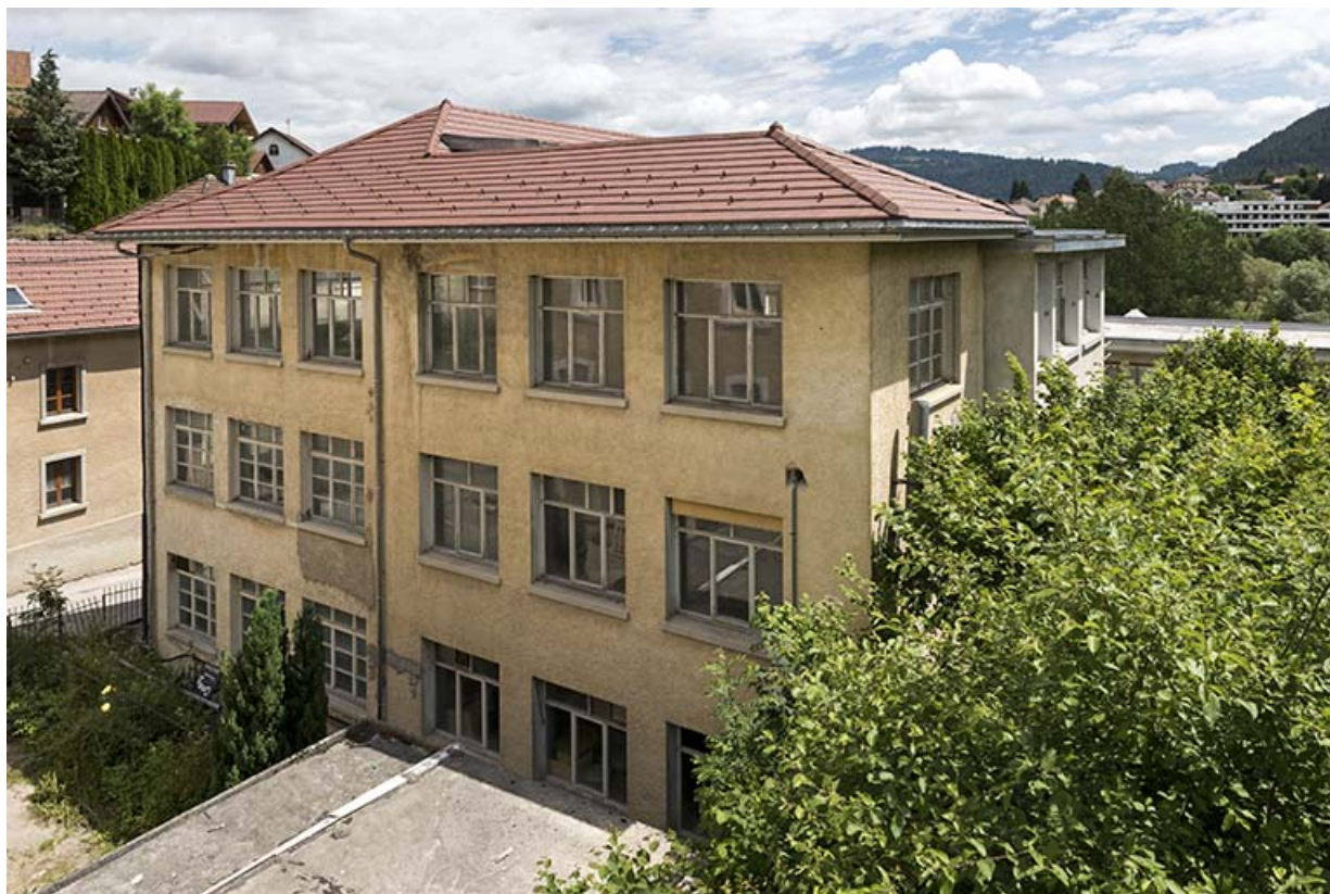
Usine : façade latérale droite, de trois quarts droite.
