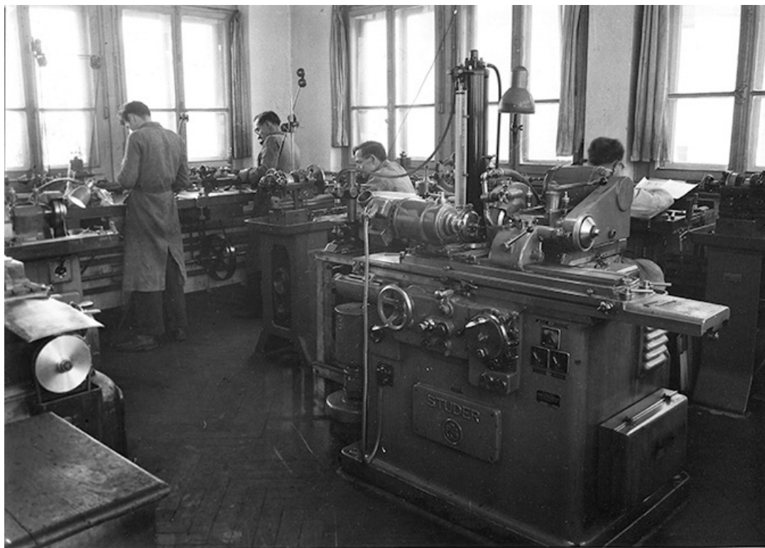
ATELIER DE MÉCANIQUE (construction d'outillage)
