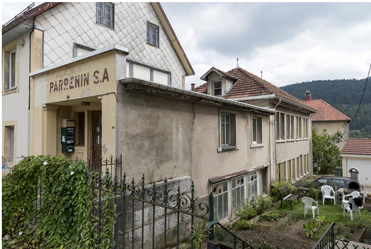
Usine : corps d'entrée et atelier de mécanique (façade latérale droite). 25, Villers-le-Lac, 5-9 rue Hippolyte Parrenin
