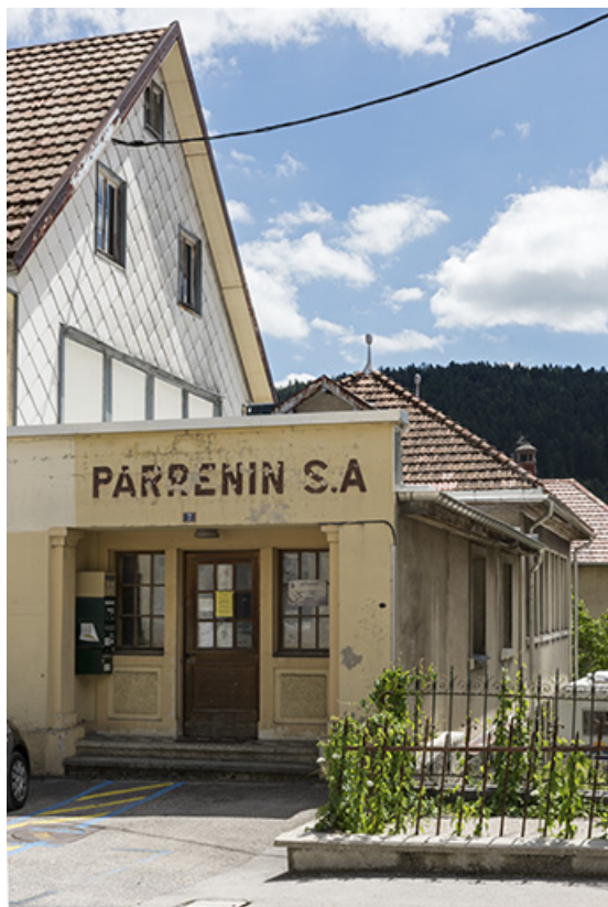
Usine : corps d'entrée, de trois quarts droite. 25, Villers-le-Lac, 5-9 rue Hippolyte Parrenin
