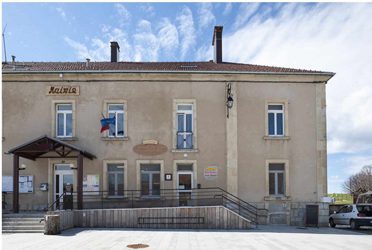
Façade nord (partie fromagerie).
