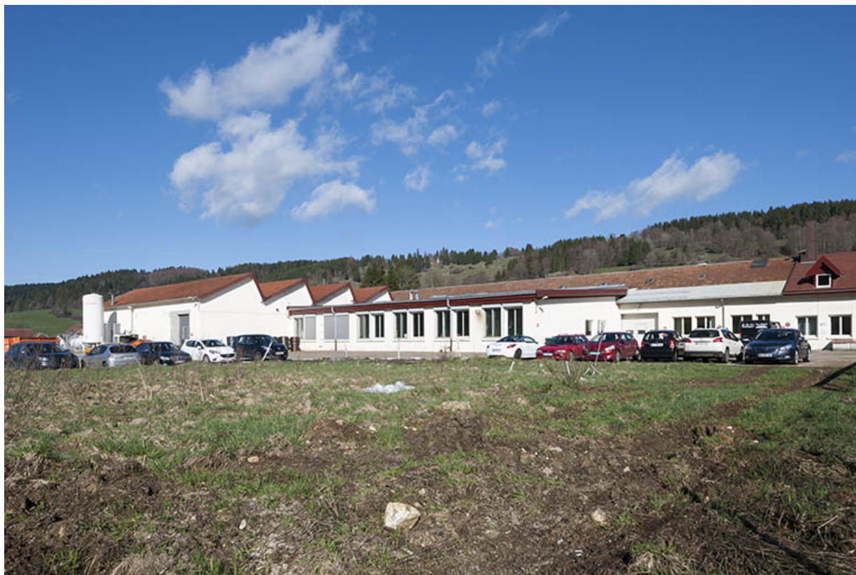
Vue depuis le sud-est.
