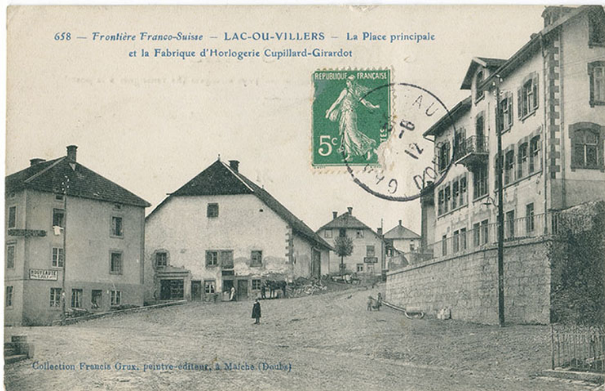
658 - Frontière franco-suisse - Lac-ou-Villers- La place principale et la fabrique d'horlogerie Cupillard-Girardot, 1er quart 20e siècle [avant 1912].
