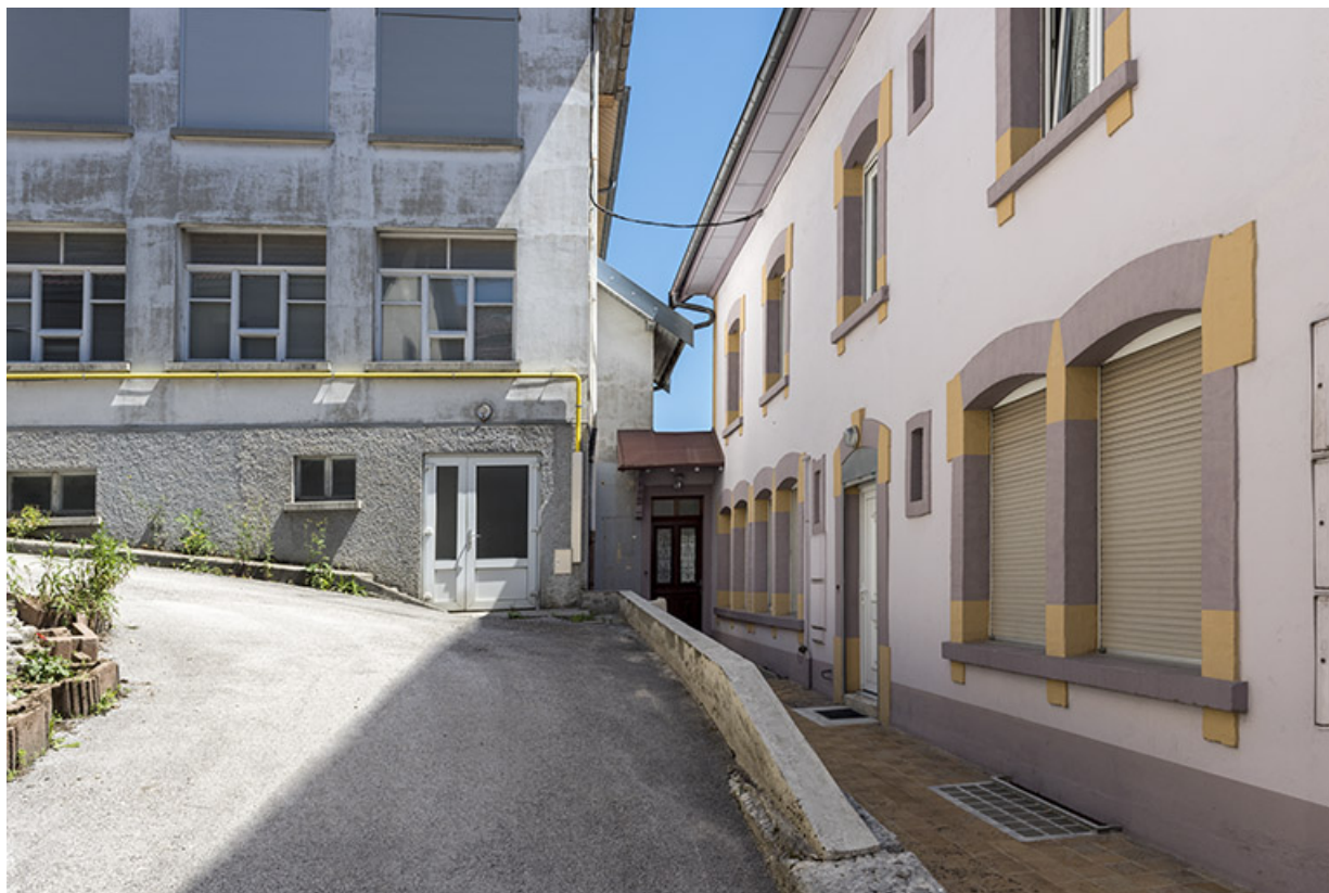
Façade postérieure, vue en enfilade, et extension de 1950.
