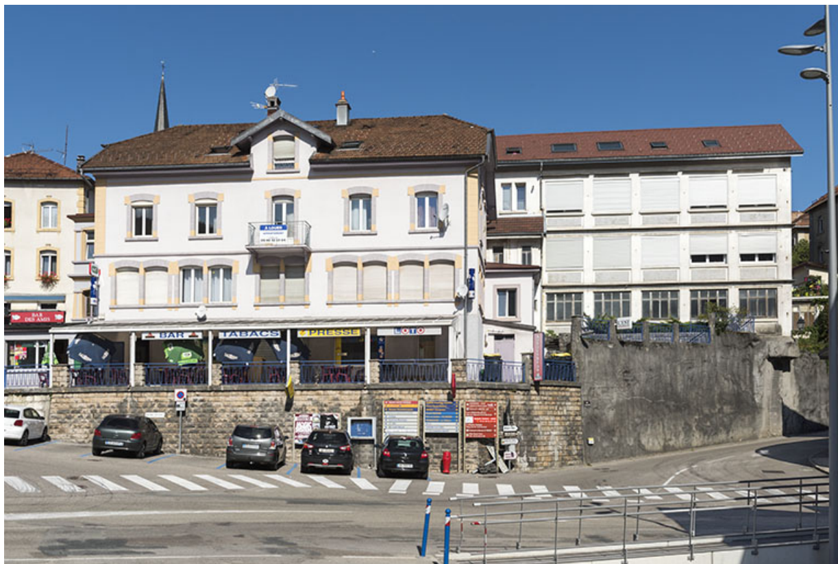
Usine n° 5 (Ebauches Cupillard), au 2 place Maxime Cupillard à Villers-le-Lac. 25, Villers-le-Lac
