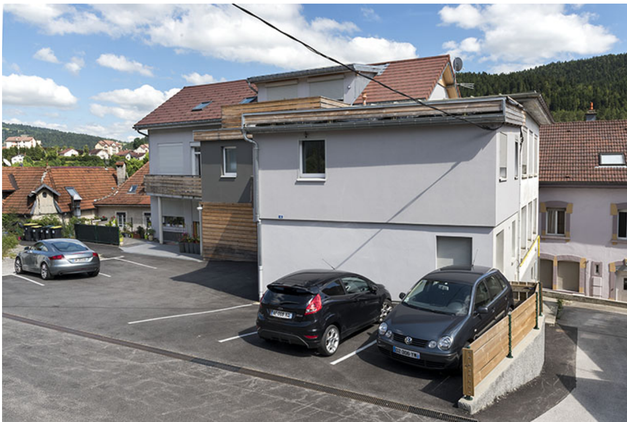
Façade postérieure : bâtiment de 1913 environ (à gauche) et extension de 1950. 25, Villers-le-Lac, 2 place Maxime Cupillard
