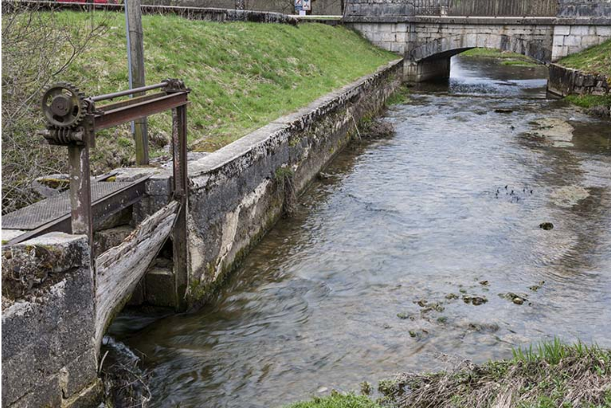
Canal d'amenée et vanne de décharge.
