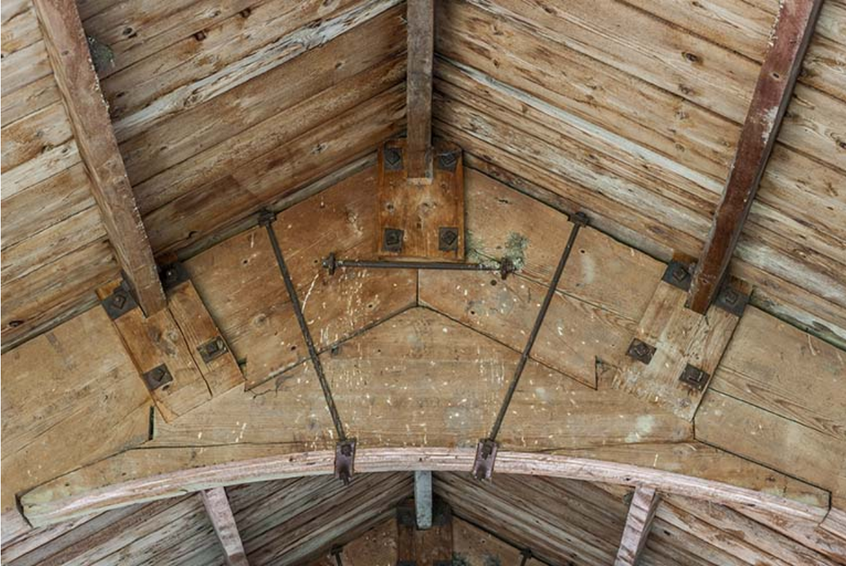
Détail de la jonction d'une ferme.
