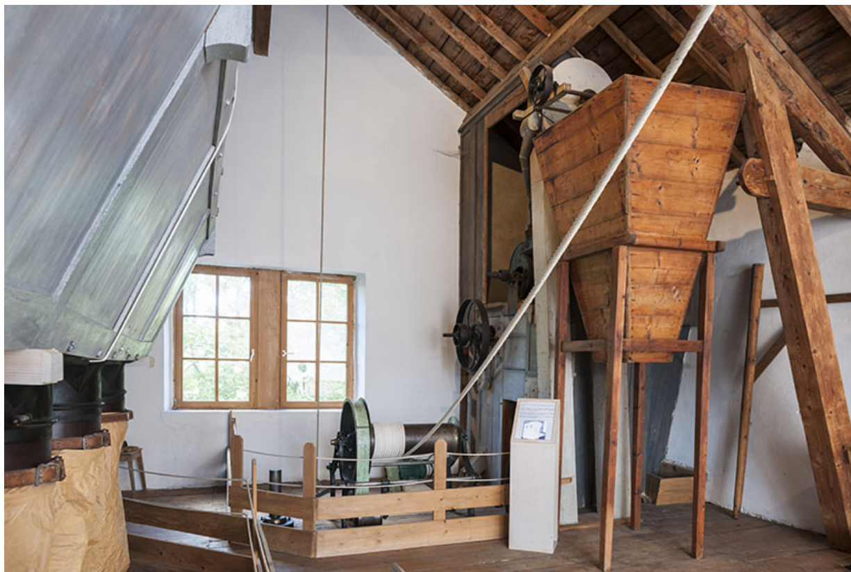
Troisième étage. Vue d'ensemble.
