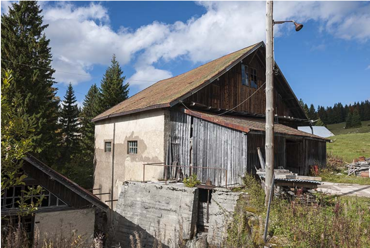
Atelier de scierie vu depuis le sud.
