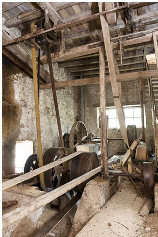
Vue d'ensemble de l'étage de soubassement. Système de transmission de la turbine hydraulique.
