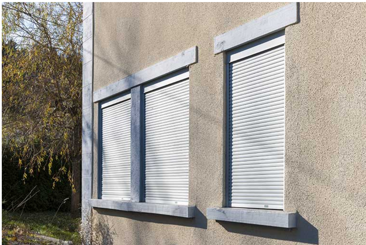
Façade latérale gauche : fenêtre horlogère. 25, Maîche, 8 rue Pasteur
