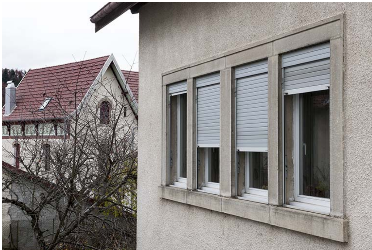
Façade latérale gauche : fenêtres multiples. 25, Maîche
