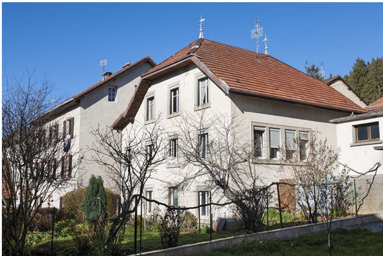
Façades postérieure et latérale gauche.
