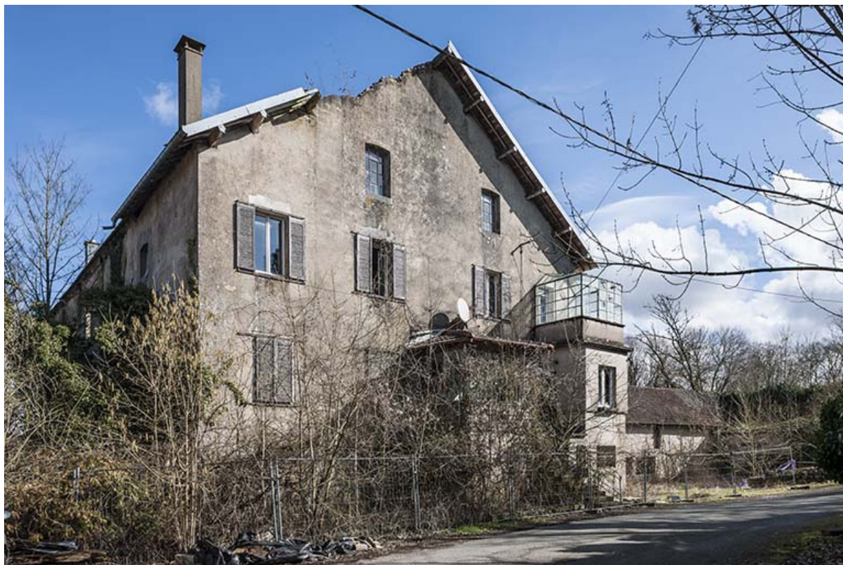
Pignon sud de l'atelier de minoterie (logement au premier plan). 25, Cussey-sur-l'Ognon, 8 rue du Canal
